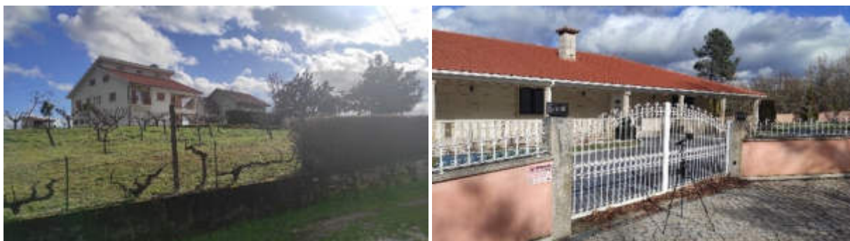
Figura 3 – Apontamento fotográfico pontos PR6 e PR7
