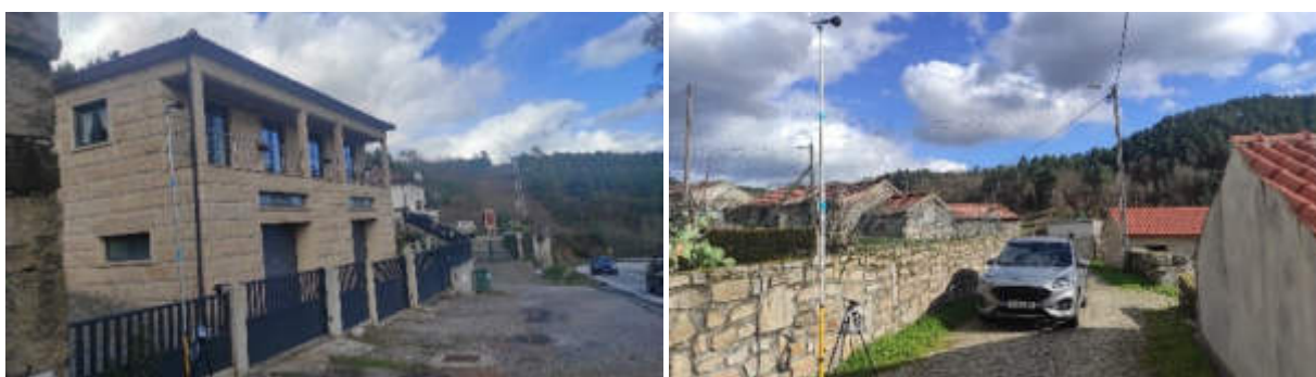
Figura 3 – Apontamento fotográfico pontos PR3 e PR4
