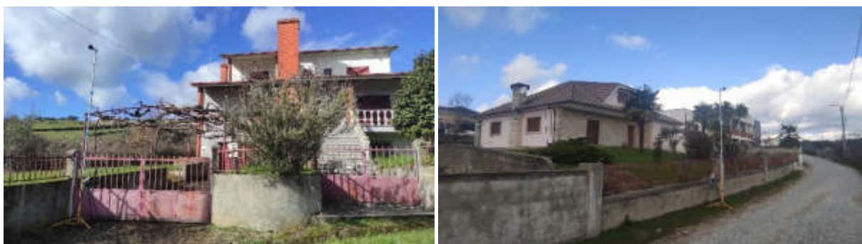
Figura 3 – Apontamento fotográfico pontos PR8 e PR9
