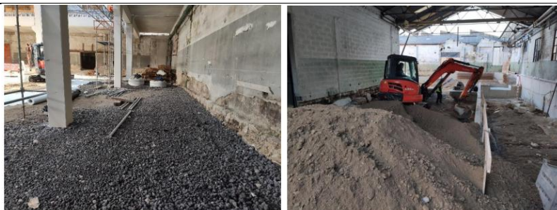
Figura 4 – Fotografias da obra do armazém de matérias-primas e novos cais de carga (Fonte: EIA, abril de 2025)
