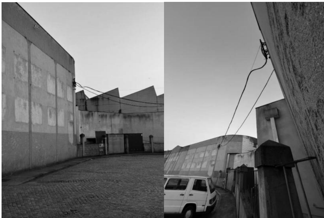
Figura 4 - Atravessamento de cabos elétricos aparentemente internos pelas zonas públicas
