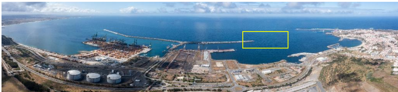
Fotografia aérea (maio de 2024) do Porto de Sines, sendo destacada a zona onde será prolongado o Molhe Leste
