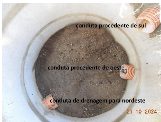
Figura 4.21 - Imagem do poço de drenagem existente na proximidade do portão de entrada
