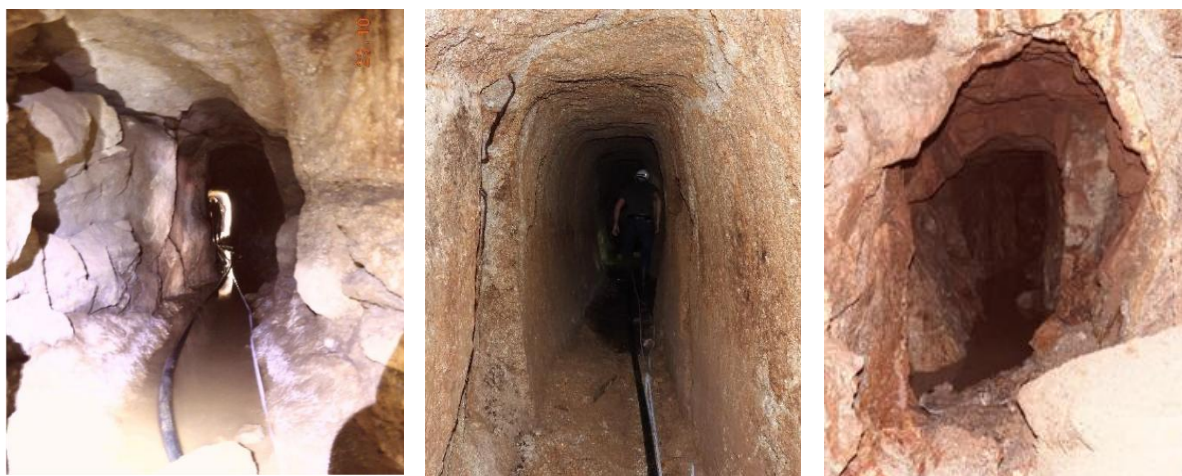
Mina de água na zona inicial, após entrada com suporte
