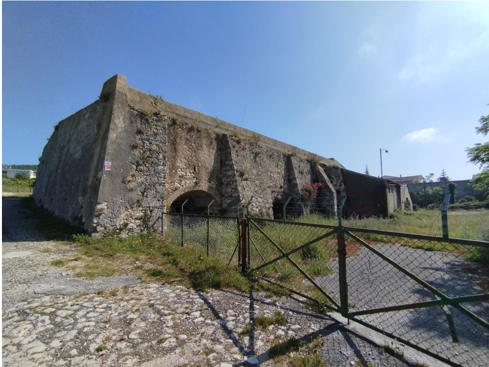
Fotografia 4.5 - Pormenor dos arcos dos fornos de cal.
