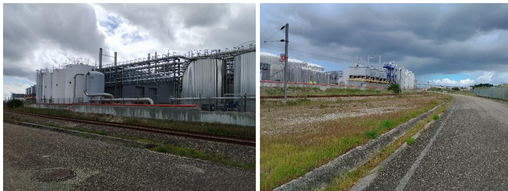
Fotografia 4.4 - Aspeto das instalações do projeto.
