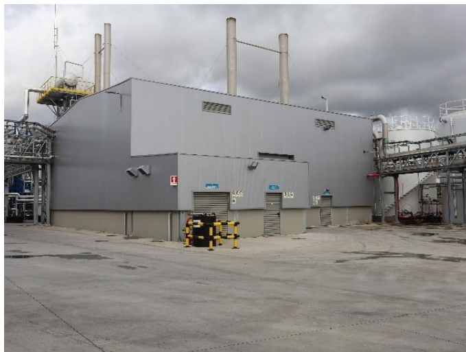
Fotografia 3.7 - Edifício das caldeiras.
