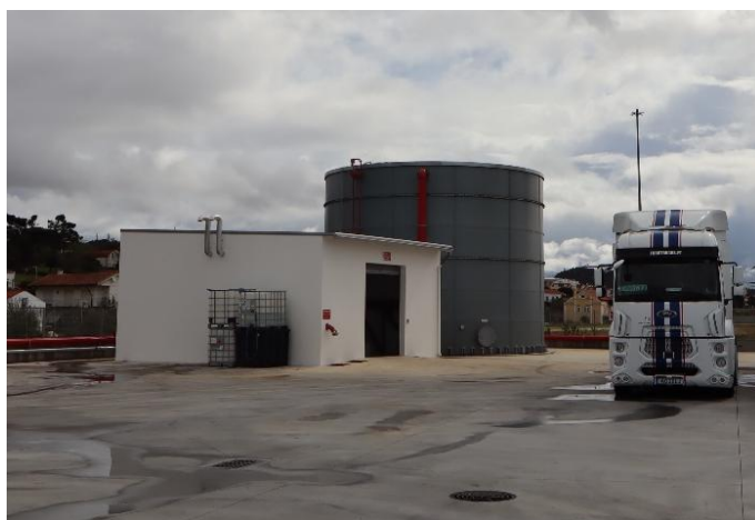
Fotografia 3.13 - Reservatório de água da rede de incêndios e central de bombagem.
