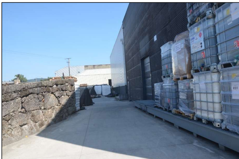
Figura 110 – VIZELPAS – zona exterior impermeabilizada.
