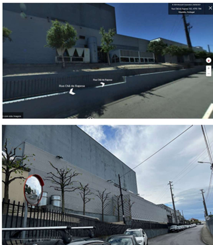
Figura 50 - Vista do lado norte antes e depois da construção da barreira acústica.
