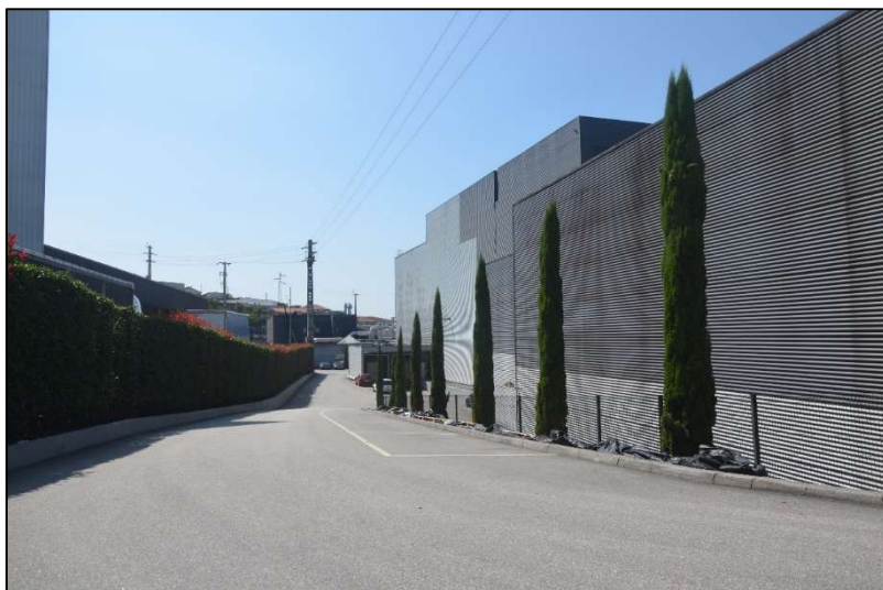
Figura 112 - Empresa VIZELPAS – Flexible Films SA. – zona exterior impermeabilizada, no limite com a Travessa das Bouças Novas.
