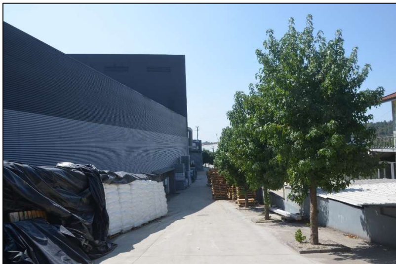
Figura 109 - VIZELPAS – zona exterior impermeabilizada.
