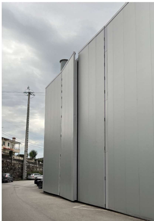
Figura 51 - Portão de manutenção do RTO, parcialmente aberto entre as 8h e as 20h.
