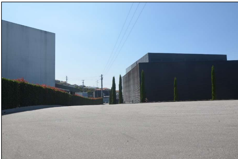
Figura 113 - Empresa VIZELPAS – Flexible Films SA. – zona exterior impermeabilizada.
