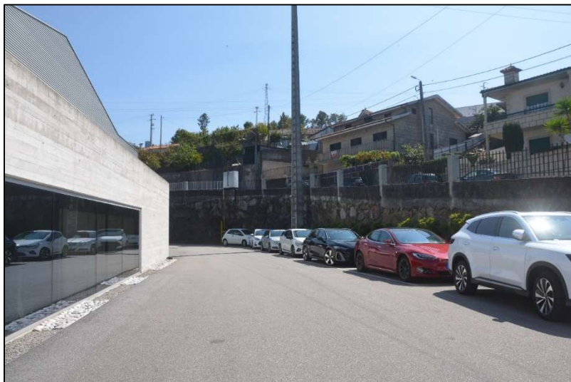
Figura 111 - VIZELPAS – zona exterior impermeabilizada, no limite com a Travessa das Bouças Novas.
