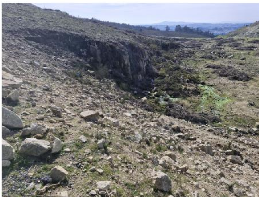
Fot. 6 – Corte existente em local ainda por escavar.
