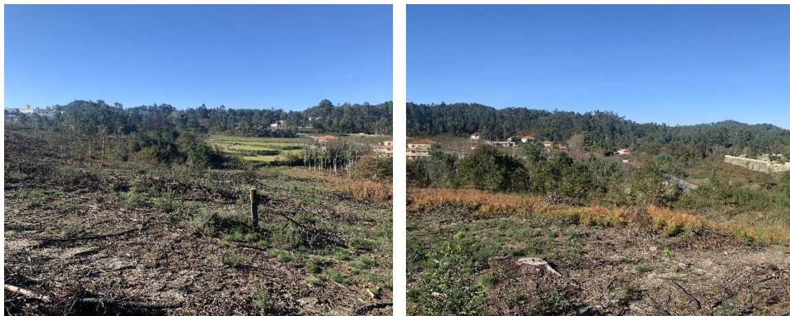
Figura 95 – Situação após intervenção.
