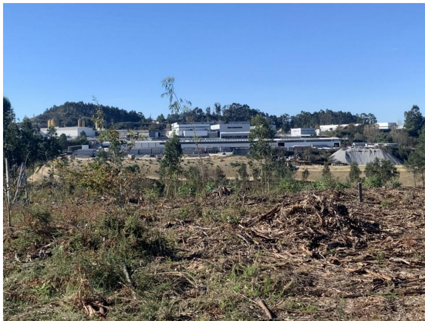
Figura 93 – Edifícios industriais no concelho de Felgueiras (Zona Industrial de Cabeça de Porca) vistos da área da Zona Industrial de Regadas I.
