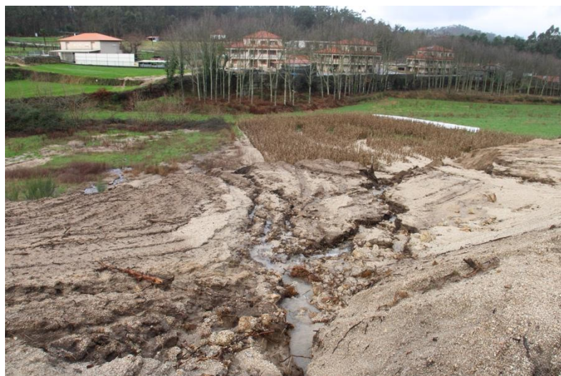
Figura 80 – Erosão linear ocorrida no setor norte, derivada de episódios de elevada pluviosidade.
