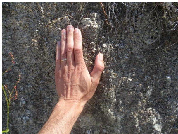
Figura 63 – Aspeto de corte (antigo) em talude.
