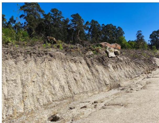
Figura 34 – Frente de corte ilustrando a textura grosseira, a ausência de matéria orgânica e a elevada permeabilidade do material mineral profundo.
