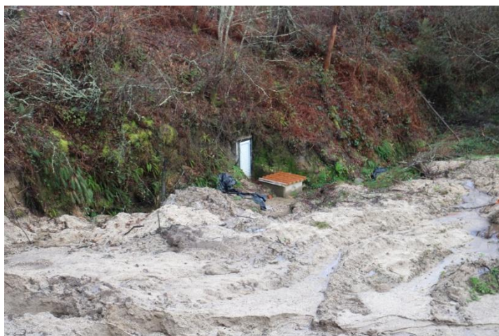
Figura 82 – Mina de água.
