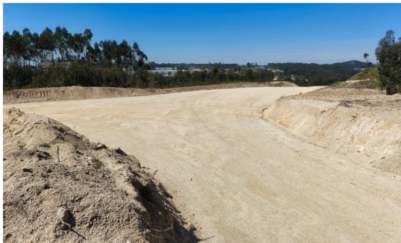
Figura 74 – Ponto de observação para noroeste.
