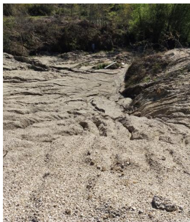
Figura 41 – Fenómenos de ravinamento .
