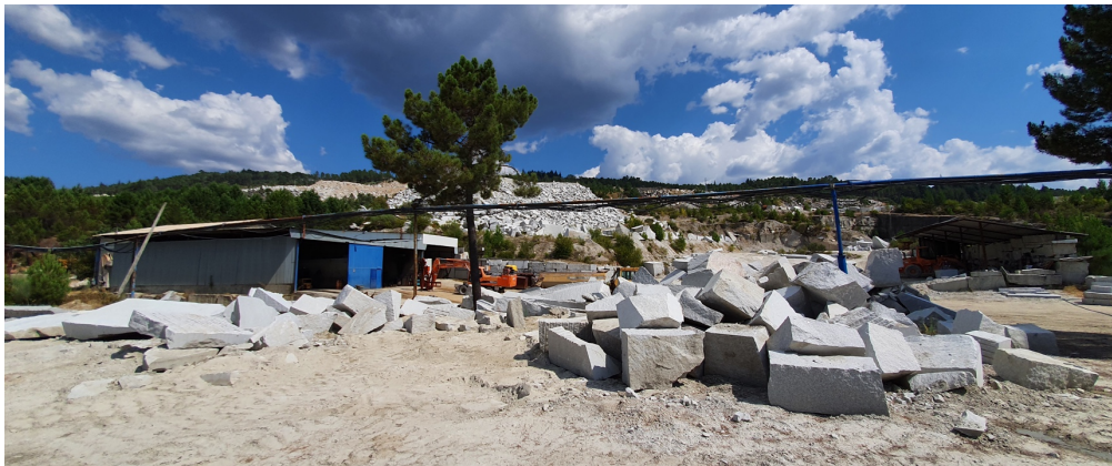
Figura 13: Fotografia da oficina e armazém existente na área a licenciar das pedreiras Pedreira n.º 5144 “Soutelinho Novo” e Pedreira n.º 4813 “Ribeiral” (fotografia designada por F12). É também visível a rede de ar comprimido e a escombeira.
