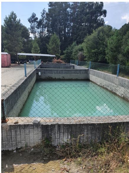
Figura 6: Fotografia das bacias de decantação existentes nas pedreiras Pedreira n.º 5144 “Soutelinho Novo” e Pedreira n.º 4813 “Ribeiral” (fotografia designada por F5). Ao fundo o parque de estacionamento de veículos ligeiros e na periferia a cortina arbórea existente no limite da área a licenciar.
