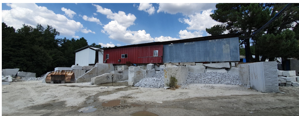
Figura 11: Fotografia da área de produção de cubos (pertencente à transformação - área industrial) das pedreiras Pedreira n.º 5144 “Soutelinho Novo” e Pedreira n.º 4813 “Ribeiral” (fotografia designada por F10).
