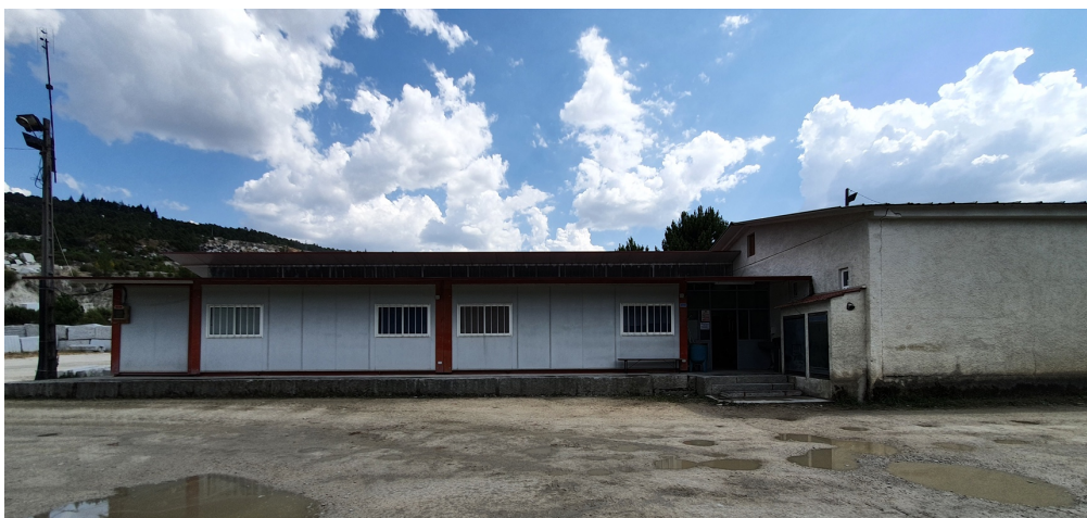
Figura 9: Fotografia das instalações sociais e do escritório das pedreiras Pedreira n.º 5144 “Soutelinho Novo” e Pedreira n.º 4813 “Ribeiral” (fotografia designada por F8).
