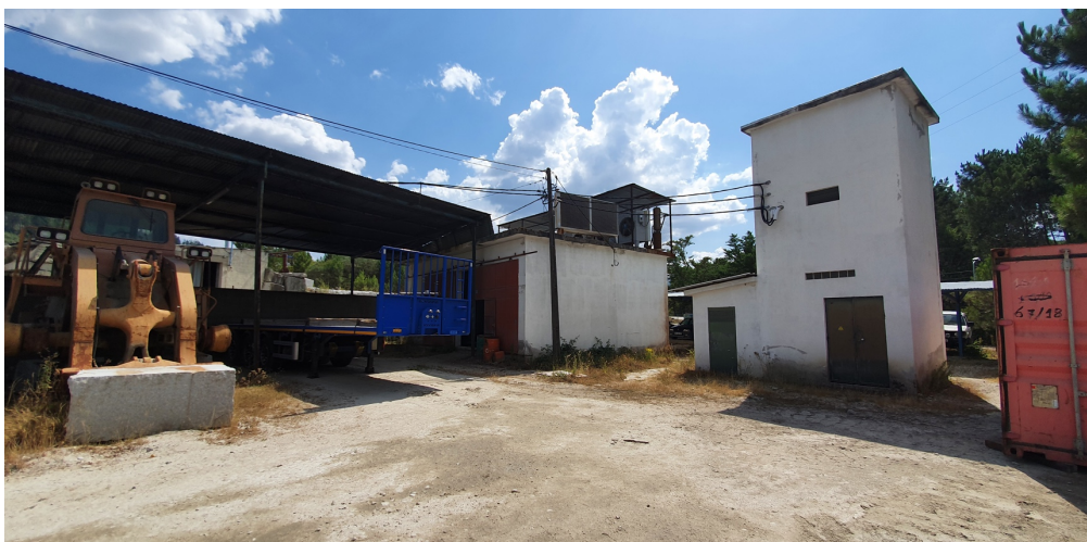
Figura 5: Fotografia da área de estacionamento de camiões e do PT existentes na área das pedreiras Pedreira n.º 5144 “Soutelinho Novo” e Pedreira n.º 4813 “Ribeiral” (fotografia designada por F4).
