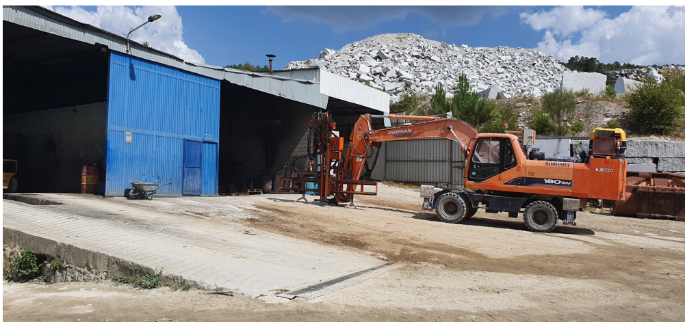
Figura 14: Fotografia da oficina e armazém existente na área a licenciar das pedreiras Pedreira n.º 5144 “Soutelinho Novo” e Pedreira n.º 4813 “Ribeiral” (fotografia designada por F13).
