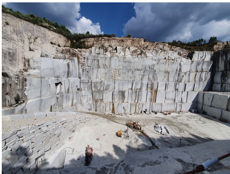
Figura 16: Fotografia da frente de exploração da Pedreira n.º 5144 “Soutelinho Novo” – vista para este (fotografia designada por F15).
