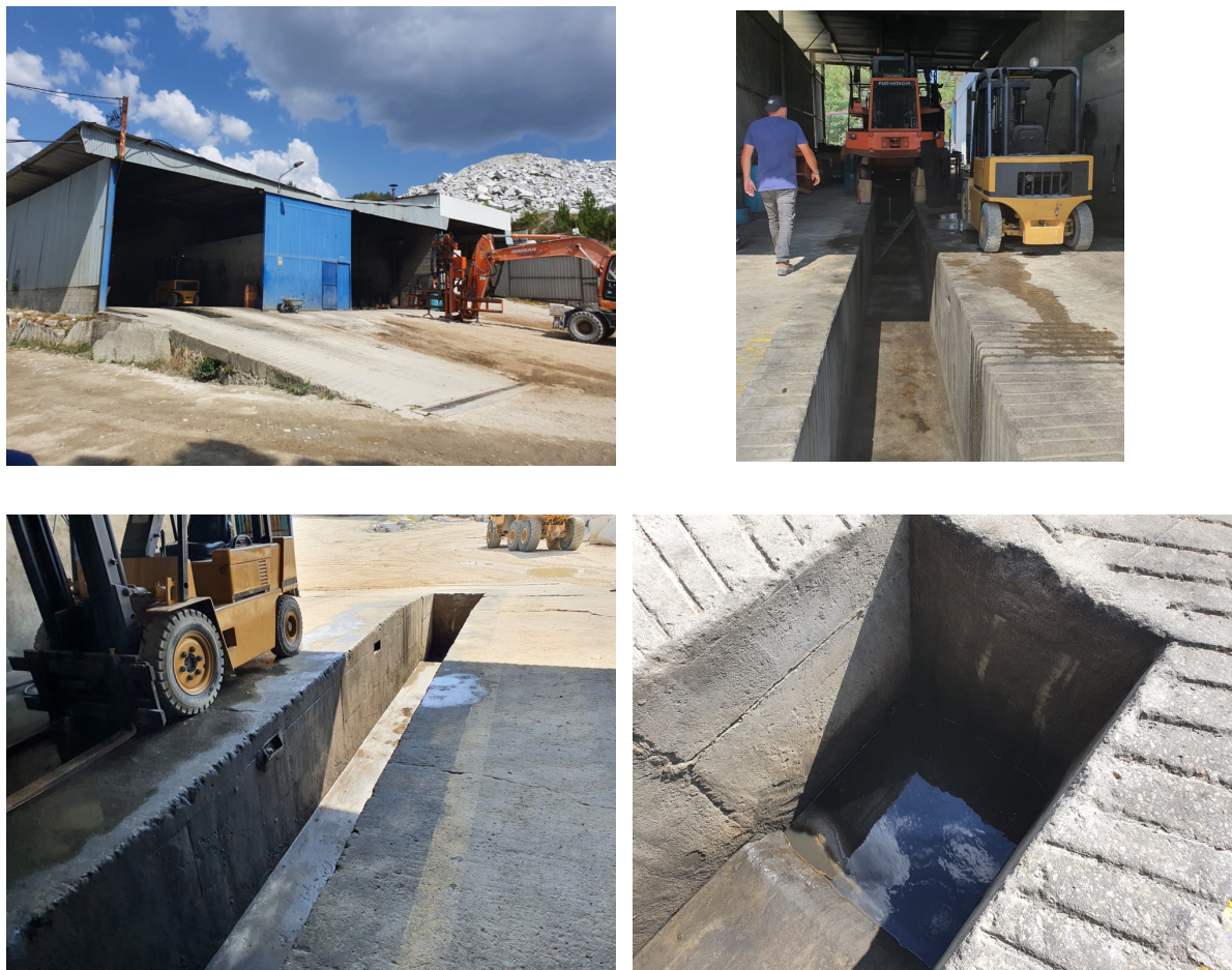
Figura 76: Fotografias da oficina evidenciando a fossa de mudanças de óleo e manutenções.
