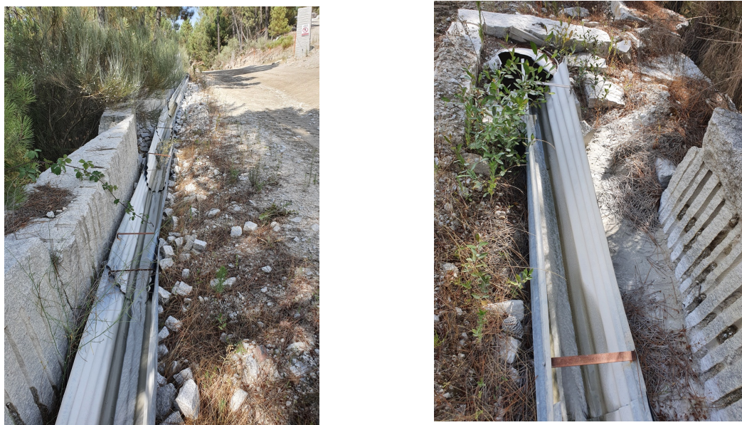
Figura 75: Fotografia da caleira de transporte de água proveniente do corte com as máquinas de fio diamantado.
