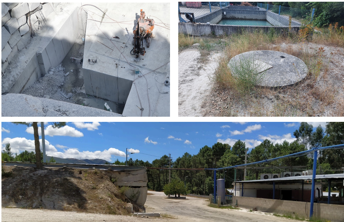
Figura 12: Fotografia da frente de exploração evidenciando o consumo de água pelas máquinas de fio diamantado e a tubagem para o transporte da água.
