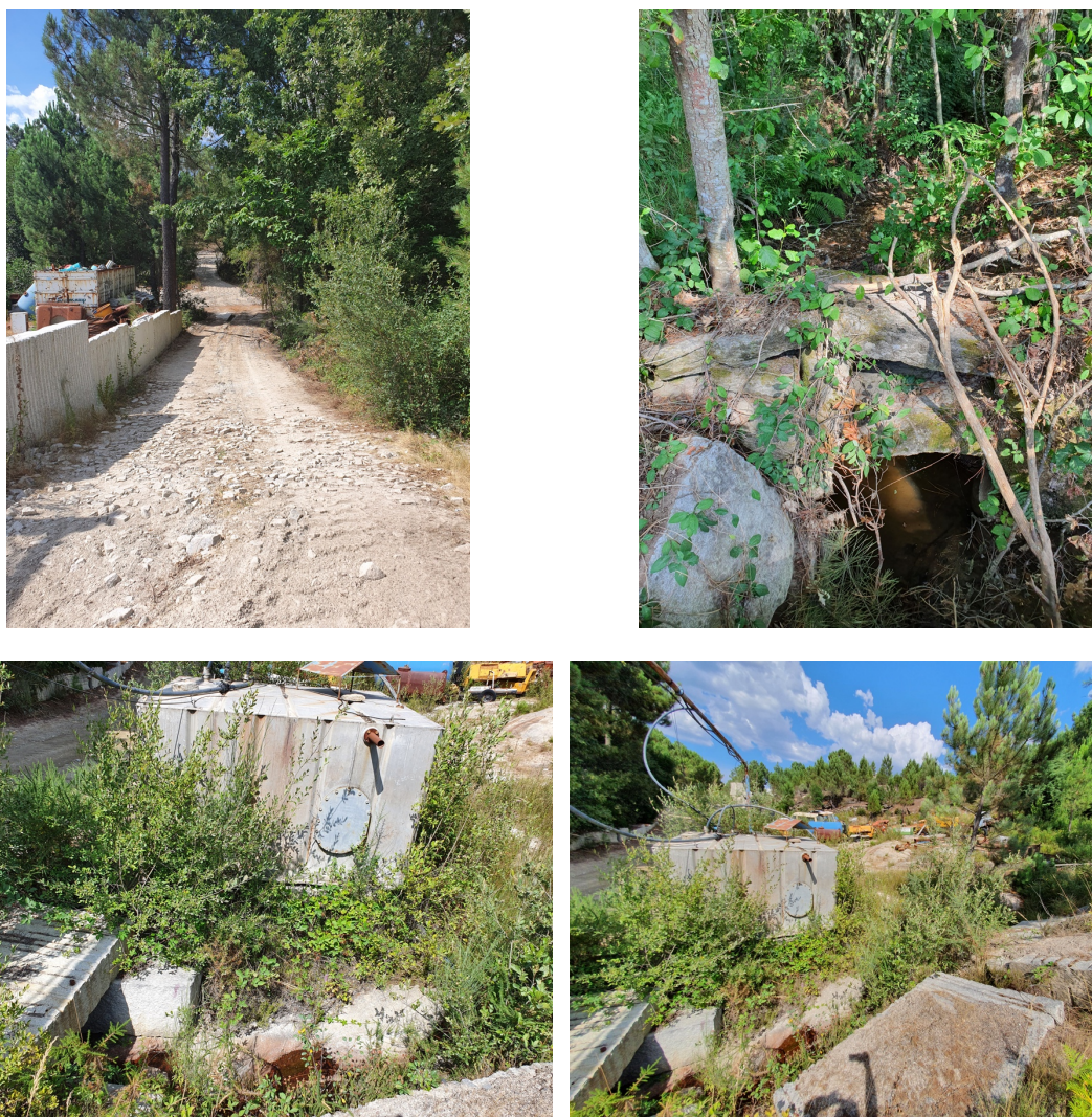
Figura 72: Registo fotográfico da linha de água que atravessa a área a licenciar (5).
