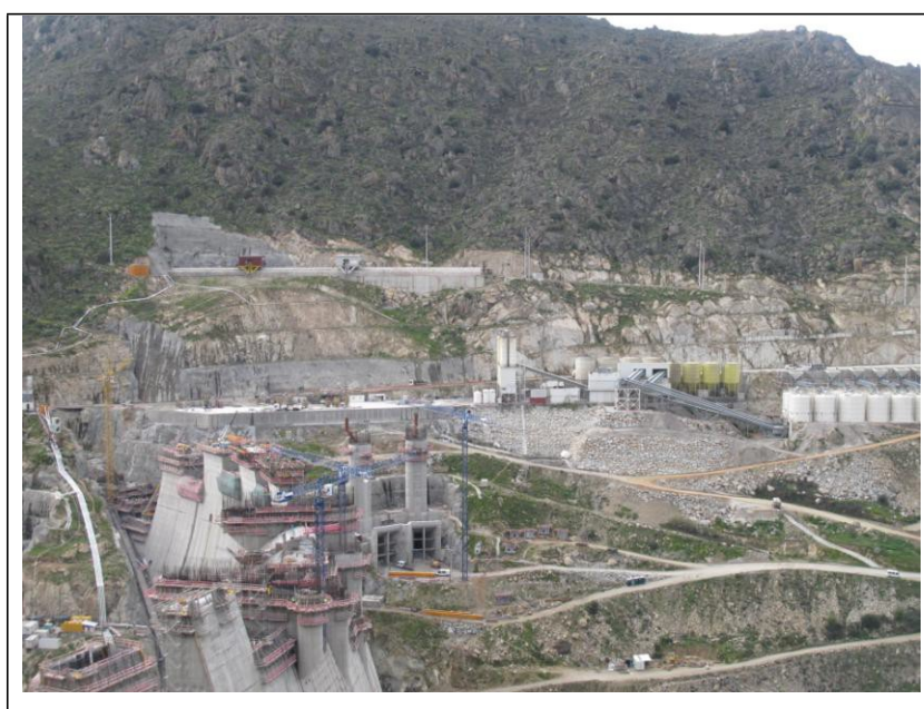
F13 – Barragem – Central de betão e frente da tomada da água
