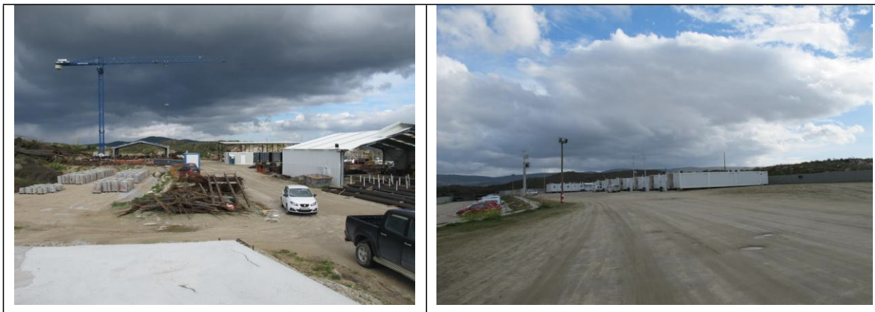
F12 – Estaleiro Industrial e instalações sociais do FE
