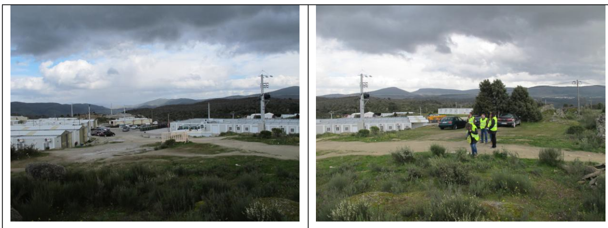
F8 – Estaleiro Social do ACE, dormitórios e cantina
