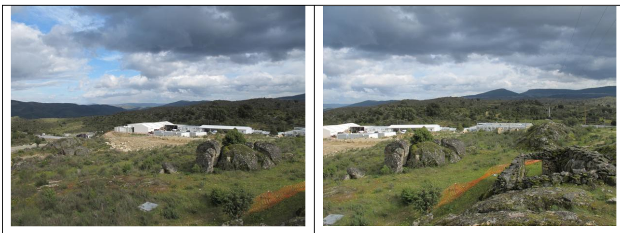
F7 – Escritórios do ACE e da EDP/Fiscalização – fase de construção
