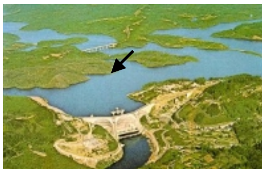
Figura 3 – Vista aérea da Barragem e Albufeira da Aguieira, com indicação aproximada da localização do Ancoradouro (fotografia anterior à intervenção associada ao empreendimento turístico Vale d’Aguieira).
