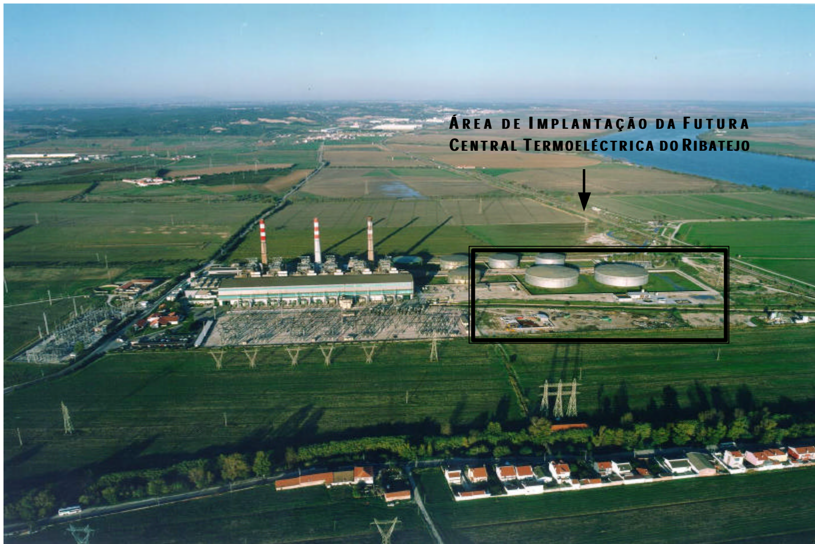
FIGURA 3.2 VISTA DA ÁREA DE IMPLANTAÇÃO DA CENTRAL
