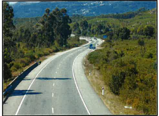
Foto 4: IP5 entre os nós de Fornelo e Couto de Cima (vista do viaduto).
