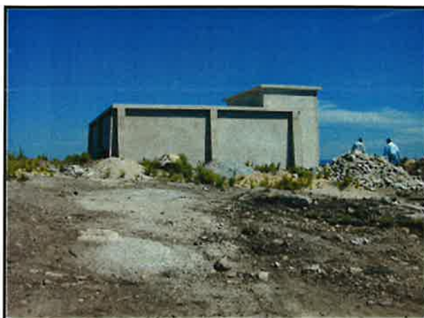
Foto 9: Edificação em fase de construção detectada junto à área de exploração de Routar (vista lateral).
