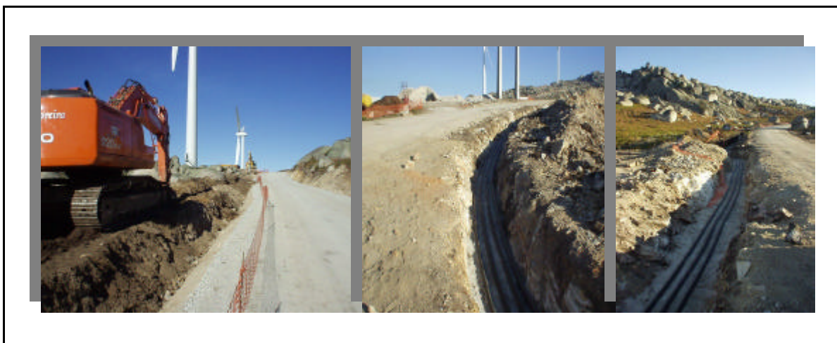
Figura 7 – Vala para instalação dos cabos eléctricos.
