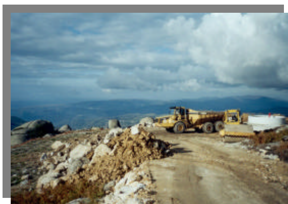
Fotografia 2 – Preparação da plataforma provisória para montagem dos aerogeradores.
