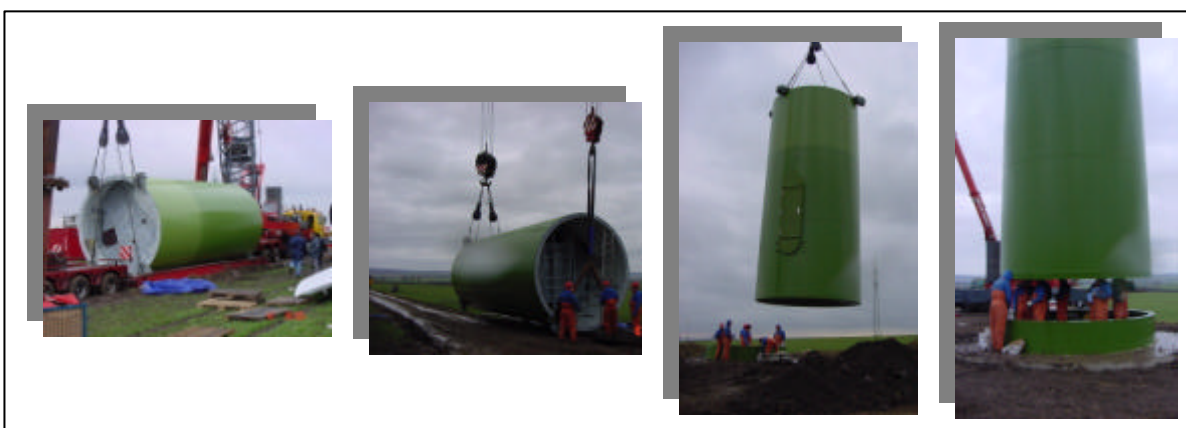
Figura 5 – Montagem da torre de um aerogerador.
