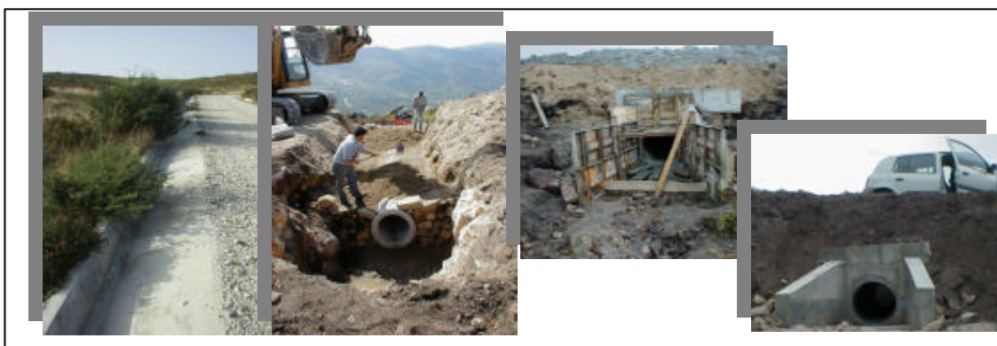
Figura 3 – Valeta e construção de uma passagem hidráulica.
