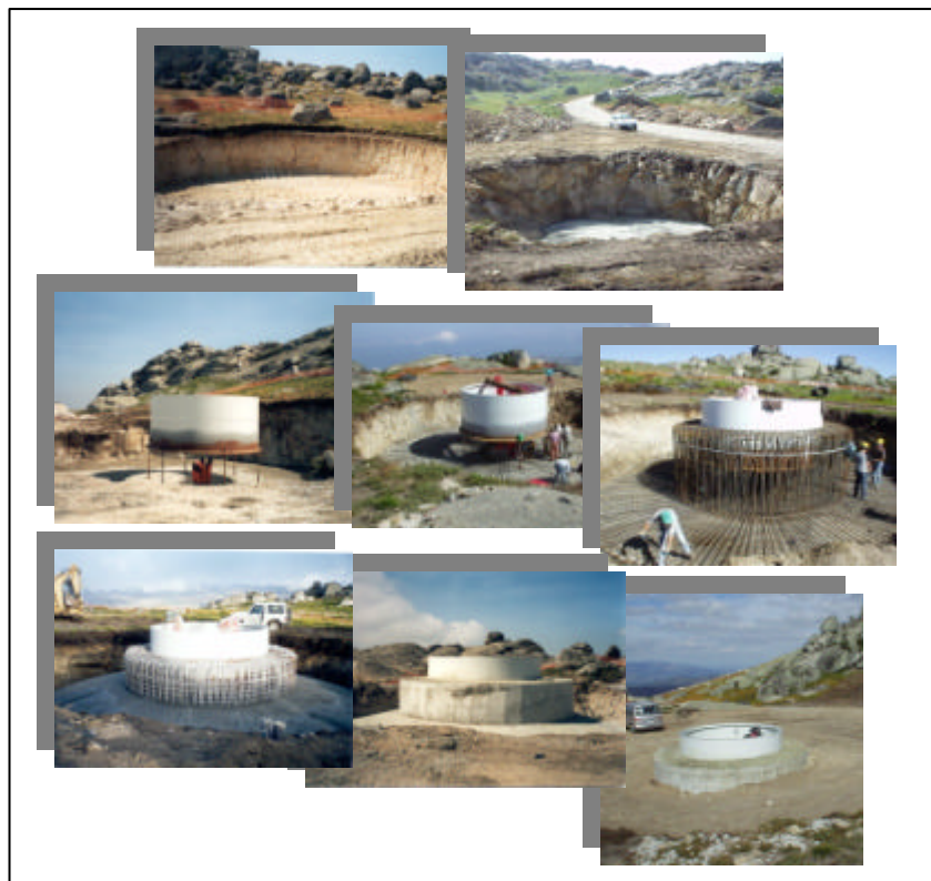
Figura 4 – Execução da fundação da torre de um aerogerador.
