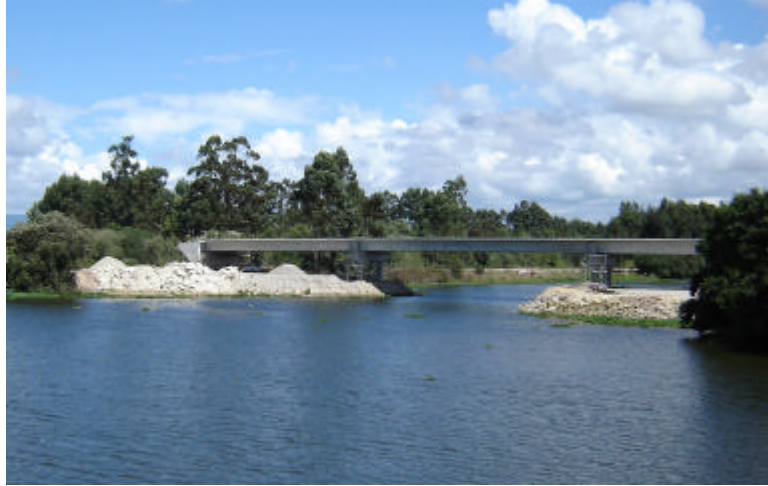
Figura 2.3 – Vista da nova ponte do Outeiro
