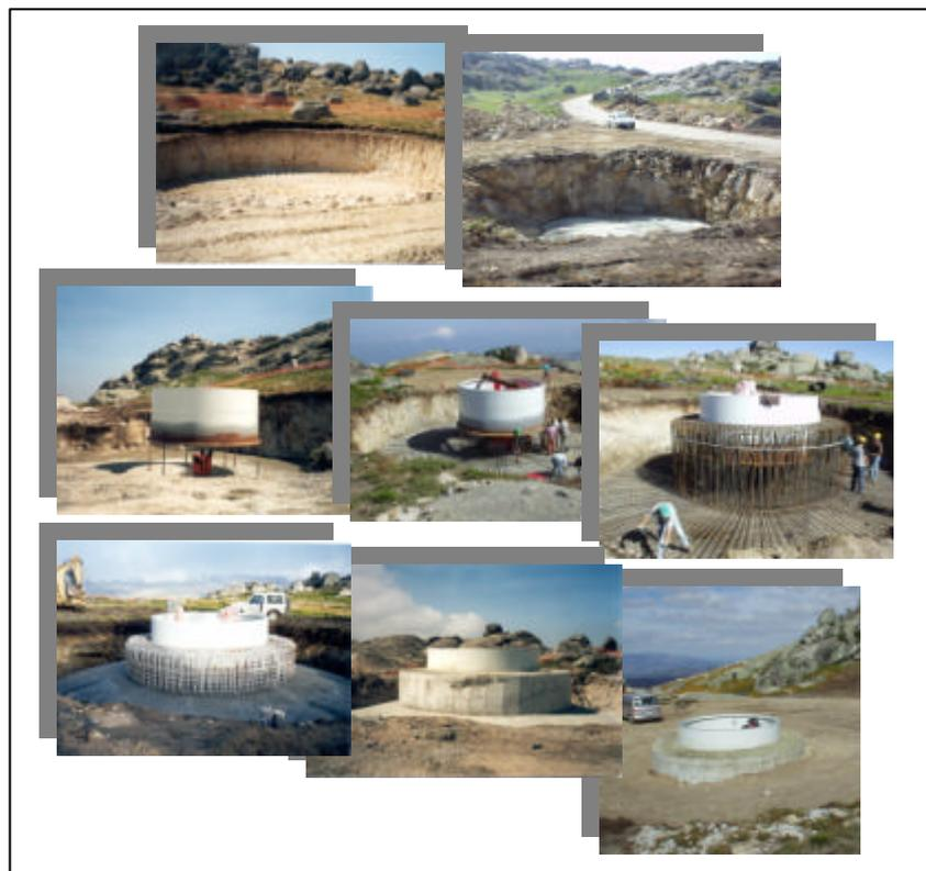
**Figura 1 – Execução da fundação da torre de um aerogerador.**
