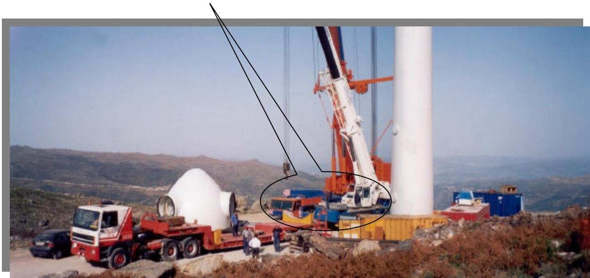
**Fotografia 3 – Ocupação e dimensão necessária de uma plataforma para a montagem de aerogeradores de 1800 kW.**
