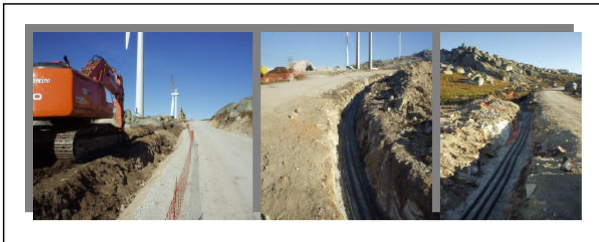
**Figura 4 – Vala para instalação dos cabos eléctricos.**
