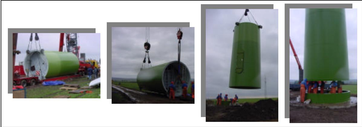
**Figura 2 – Montagem da torre de um aerogerador.**
