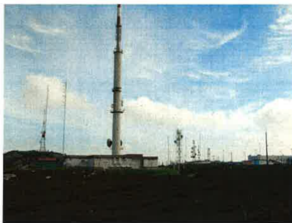
Foto 17 – Antenas existentes na zona da Foia
