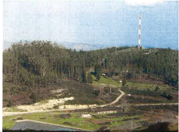
Foto 3 – Cumeada prevista para a implantação dos aerogeradores 3 e 4, vista da Foia
