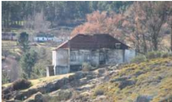
A - Habitação do diretor da Mina em fundo bairro mineiro
