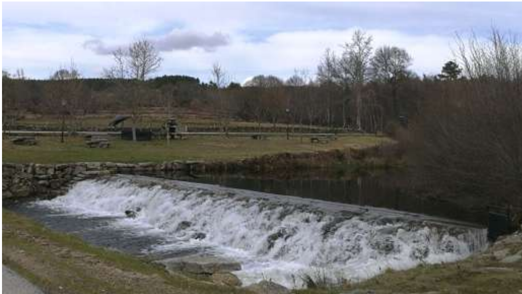
Figura 44– Rio Beça junto a uma das estradas de acesso à área da Mina de Carvalhais no quadrante Sudeste.
