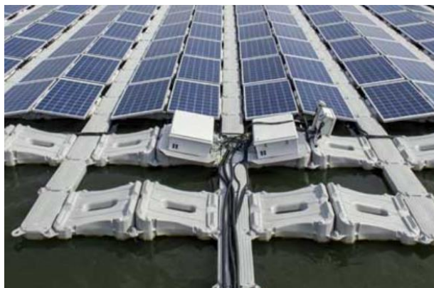
Figura 9 – Exemplo da Fixação os inversores às estruturas
