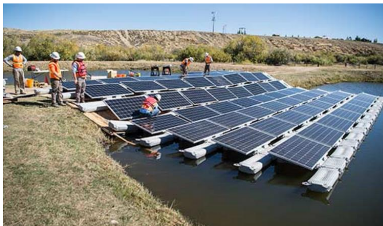
Figura 3 – Montagem das plataformas
