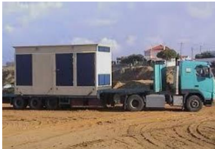
Figura 17 – Exemplo de compartimento do tipo “Kiobet” para o ponto de receção na Margem (tomada de água)
