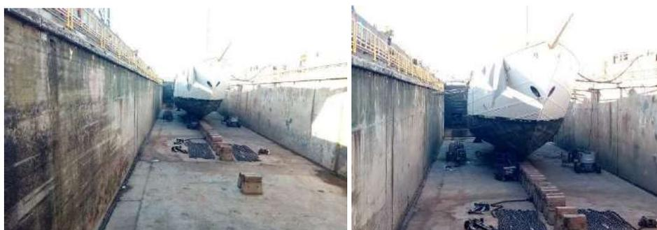
**Figura 2.14-** Termo da receção do navio, vazamento total da doca e retiro dos ferros do navio e, alocação de meios de movimentação e elevação de cargas e pessoas.
