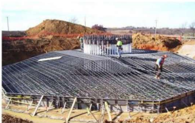
Figura 5.3: Exemplo de uma fundação de aerogerador semelhante à proposta
