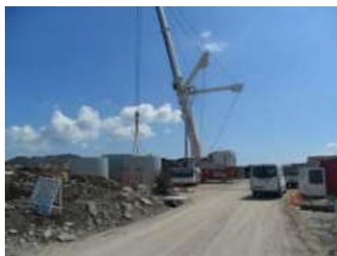
Fotografia 2.23 – Montagem da torre
