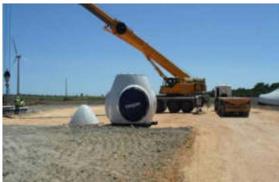
Fotografia 2.22 – Plataforma de montagem
