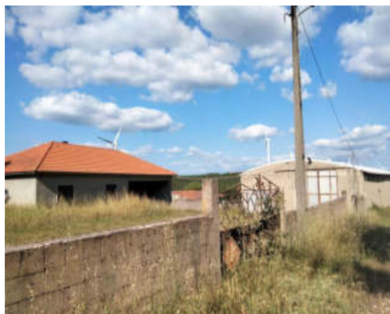
Fotografia 5.22 – Edificação aparentemente sem qualquer utilização à data da visita de campo
