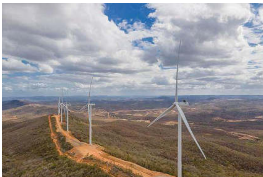
Fotografia 2.2 – Aerogeradores idênticos aos previstos instalar
