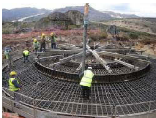
Fotografia 2.17 – Armação do ferro
