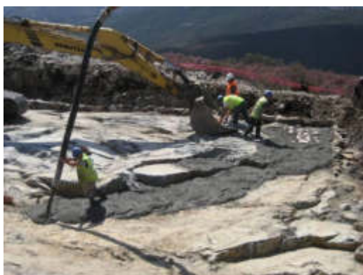
Fotografia 2.15 – Betonagem do betão de limpeza da fundação
