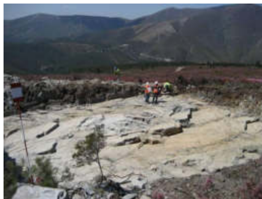
Fotografia 2.14 – Cabouco após escavação e limpeza
