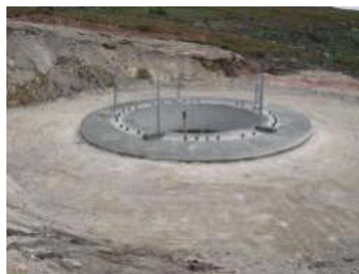
Fotografia 2.18 – Fundação aterrada
