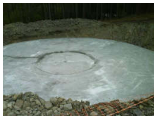
Fotografia 2.16 – Betão de limpeza
