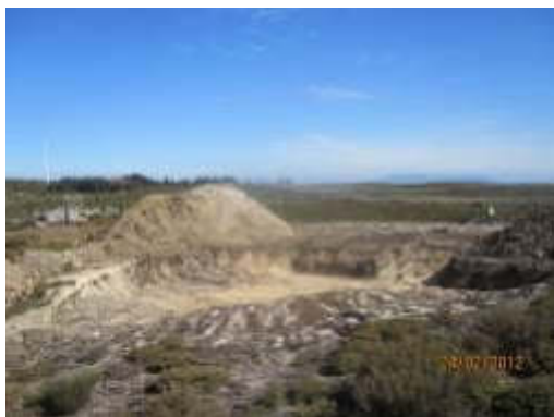
Fotografia 2.13 – Escavação do cabouco
