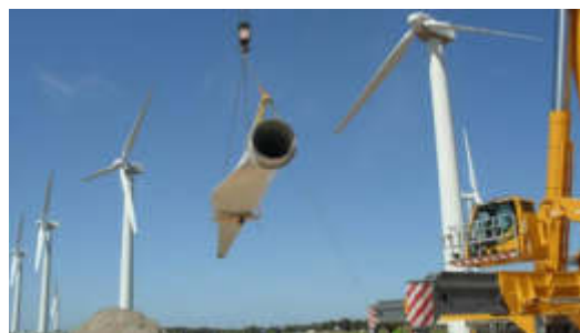
Fotografia 2.25 – Montagem de pás
