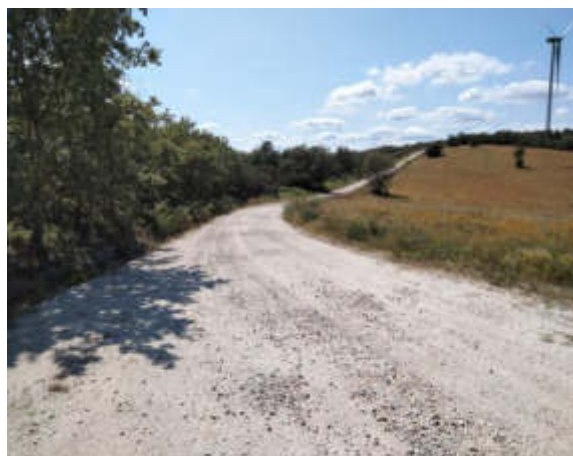
Fotografia 5.21 – Acesso principal do Parque Eólico do Sabugal
