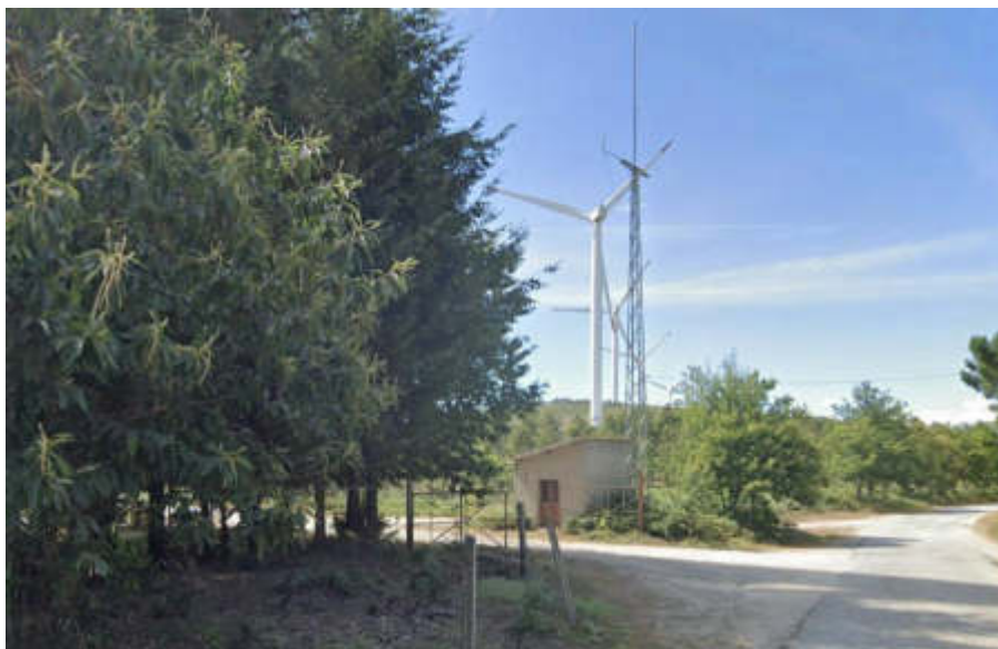
Fotografia 4.3 – Antena localizada na vizinhança do AG8-E
