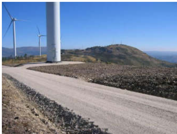
Fotografia 2.3 e Fotografia 2.4 – Plataforma de trabalho adjacente a um aerogerador, à esquerda durante a fase de montagem e à direita após a recuperação paisagística
