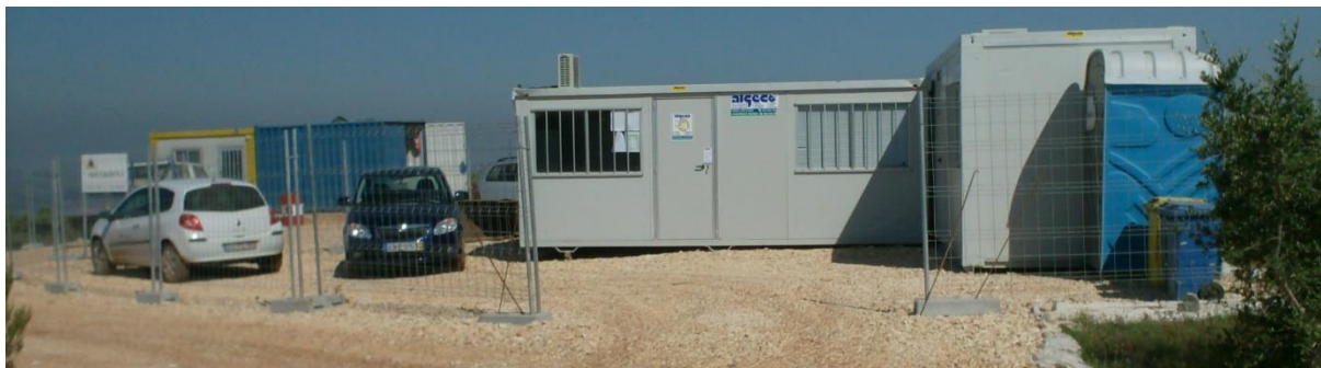
Fotografia 2 – Exemplo de um estaleiro semelhante ao que se pretende instalar.
