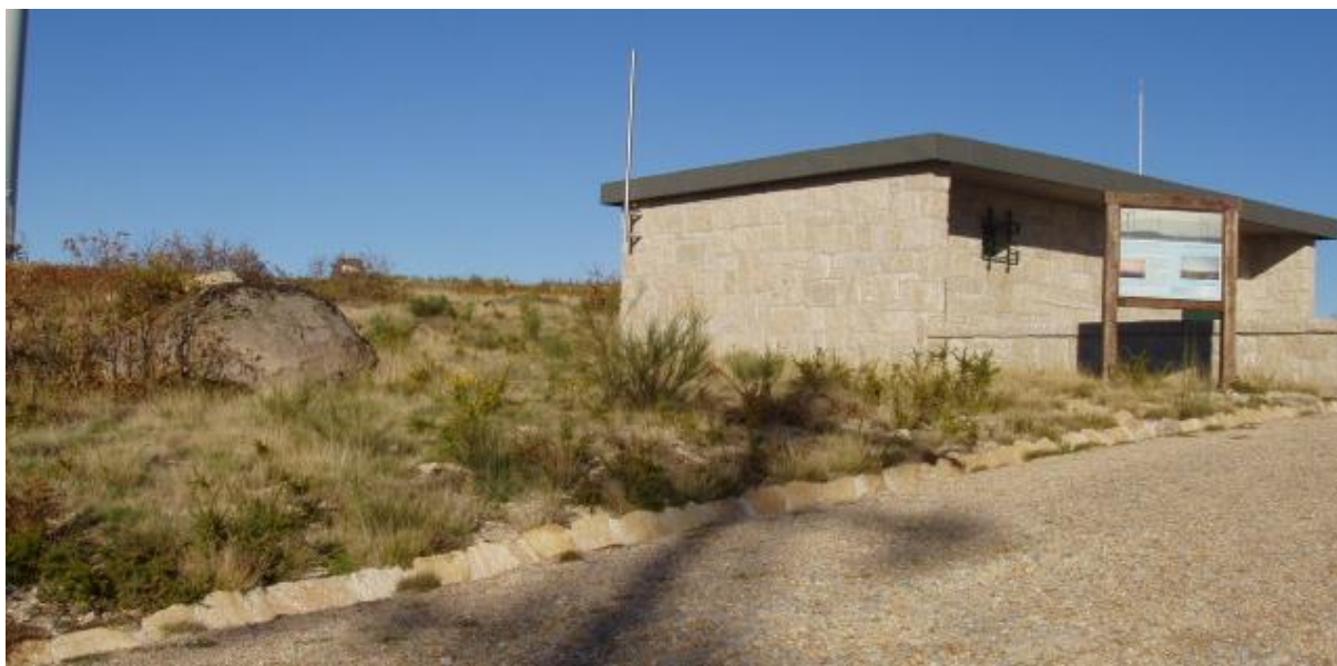
Fotografia 1 - Posto de seccionamento/Edifício de comando do Parque Eólico de Tendaís existente que será realocizado.
