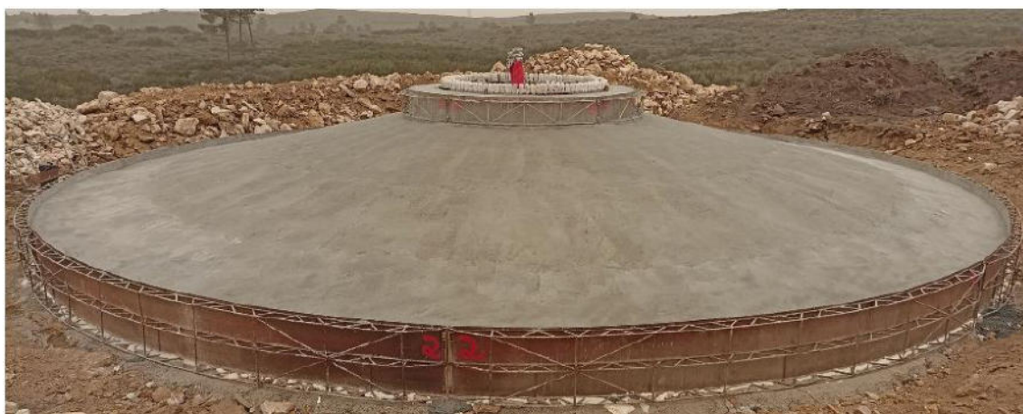
Fotografia 2.1 – Exemplo de sapata da fundação da turbina eólica.
