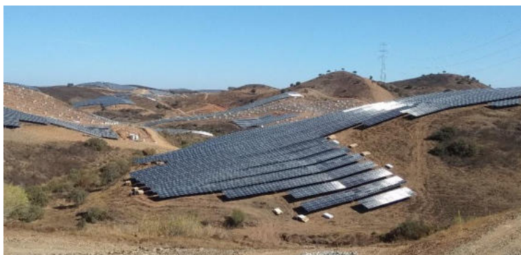
Fotografia 2.3 – Exemplo de montagem da estrutura dos módulos fotovoltaicos
