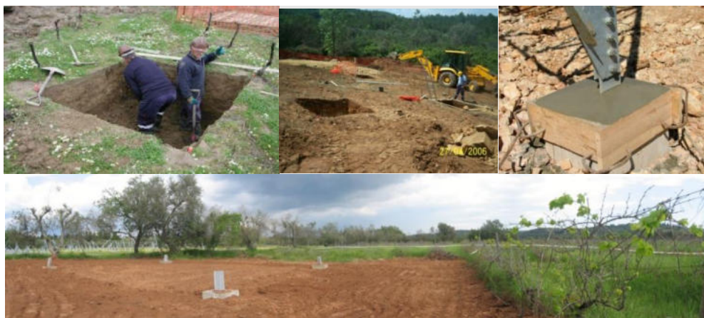
Figura 2.10 - Execução das fundações dos apoios da linha
