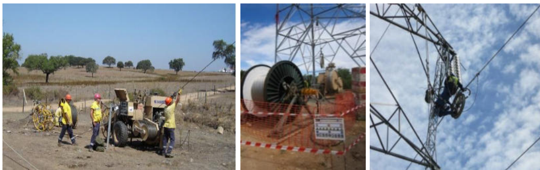
Figura 2.13 - Colocação dos cabos
