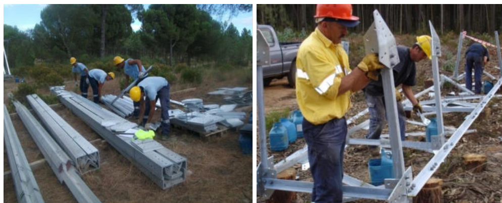
Figura 2.11 – Preparação da montagem da estrutura dos apoios
