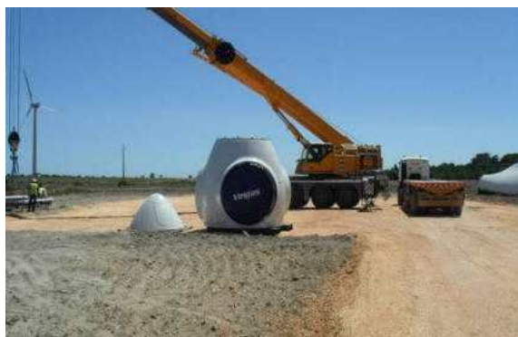
Fotografia 2.17 – Plataforma de montagem
