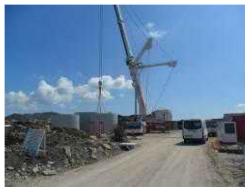
Fotografia 2.18 – Montagem da torre
