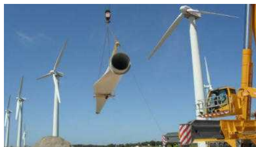
Fotografia 2.20 – Montagem de pás
