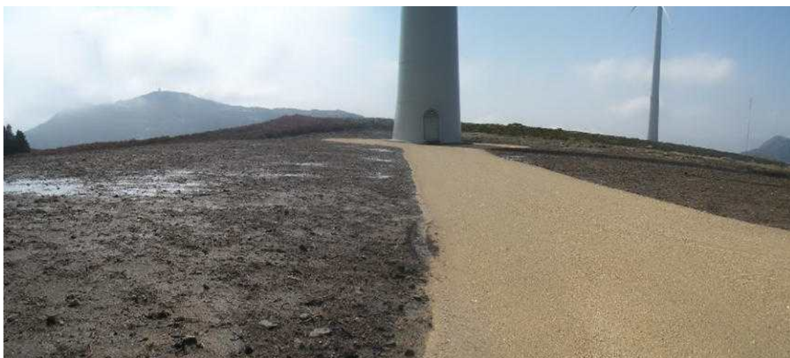
Fotografia 2.15 – Aspeto da plataforma de trabalho a ser sujeita a requalificação ambiental, ainda sem a recuperação da vegetação
