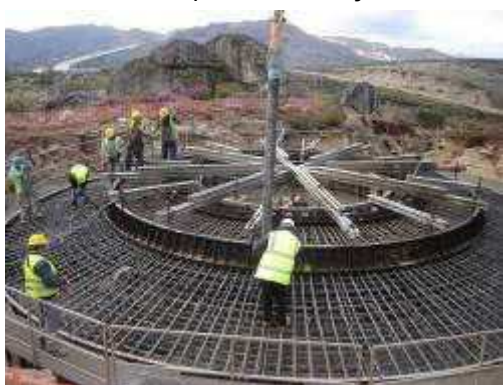
Fotografia 2.12 – Armação do aço
