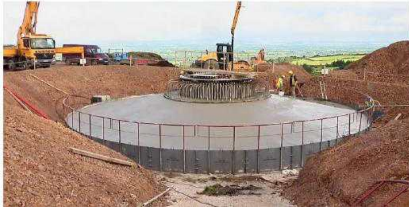
Fotografia 2.7 – Exemplo de uma fundação do aerogerador
