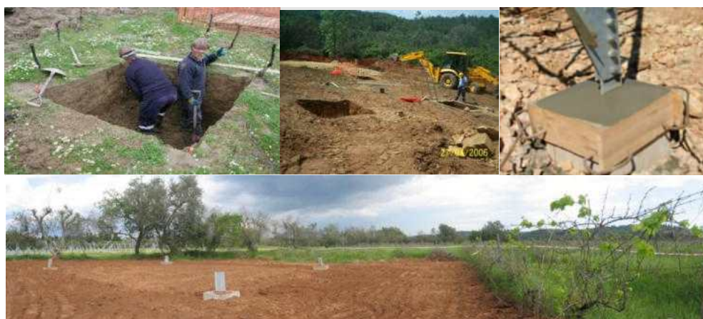
Fotografia 2.21 - Execução das fundações dos apoios da linha
