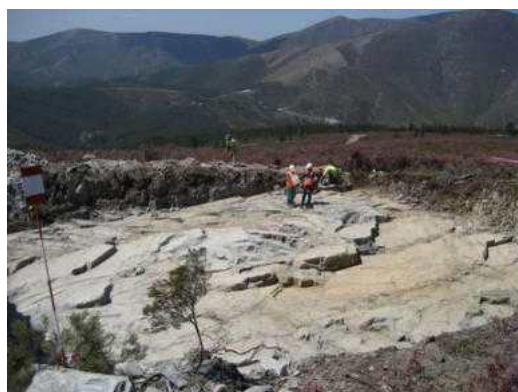
Fotografia 2.9 – Cabouco após escavação e limpeza
