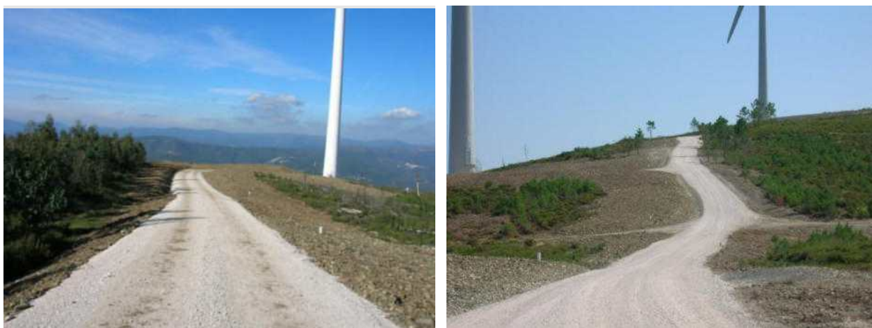
Fotografia 2.3 – Exemplo de vias de acesso após a construção de uma Central Eólica
