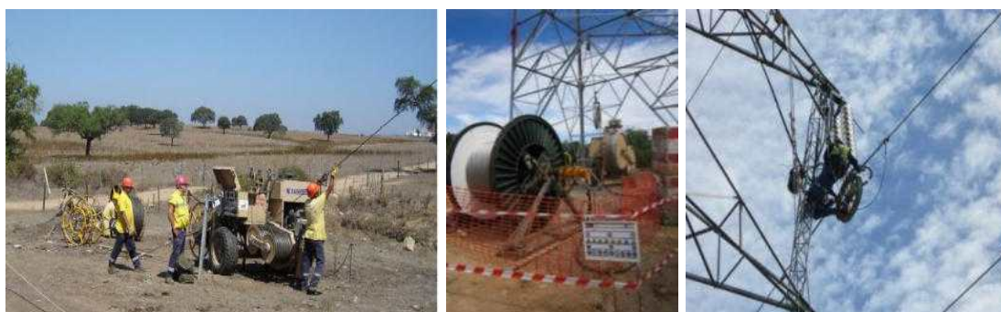
Fotografia 2.24 - Colocação dos cabos
