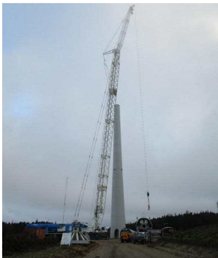
Fotografia 2.14 – Aspeto da plataforma de trabalho durante a montagem de um aerogerador
