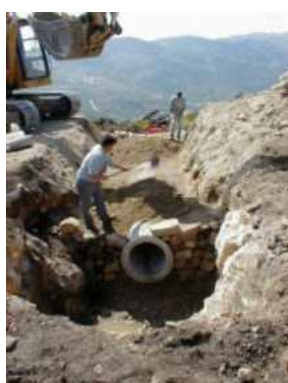
Fotografias 2.4, 2.5 e 2.6 – Construção de uma passagem hidráulica
