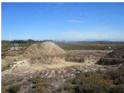
Fotografia 2.8 – Escavação do cabouco
