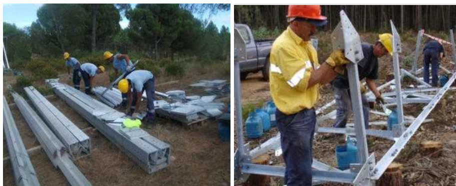
Fotografia 2.22 – Preparação da montagem da estrutura dos apoios
