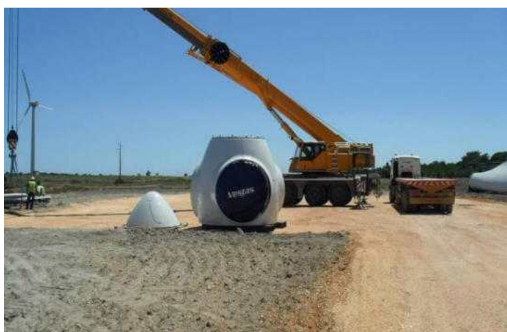
Fotografia 2.1 - Exemplo da plataforma de um aerogerador no decorrer das montagens
