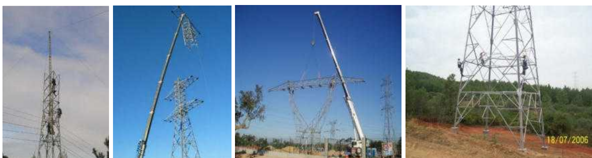
Fotografia 2.23 - Montagem da estrutura dos apoios
