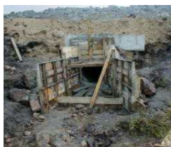
Fotografias 2.4, 2.5 e 2.6 – Construção de uma passagem hidráulica
