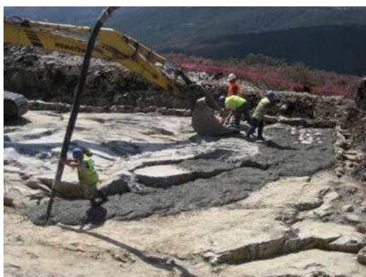
Fotografia 2.10 – Betonagem do betão de limpeza da fundação
