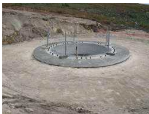
Fotografia 2.13 – Fundação aterrada
