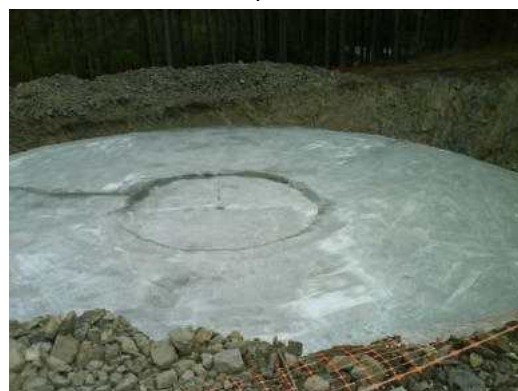
Fotografia 2.11 – Betão de limpeza
