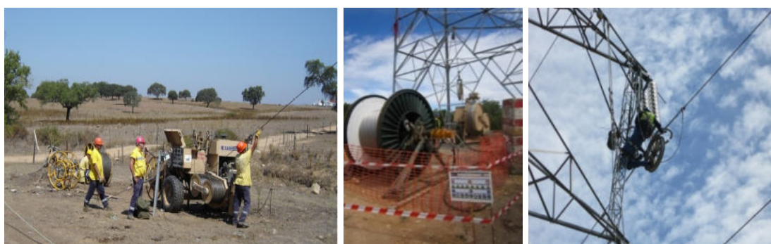
Figura 2.13 – Colocação dos cabos
