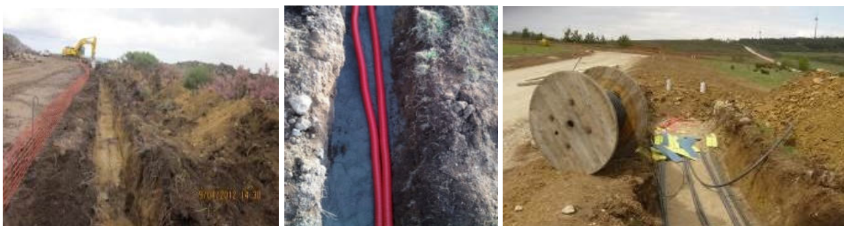
Fotografia 2.1 – Exemplo de abertura de valas para instalação de cabos elétricos
