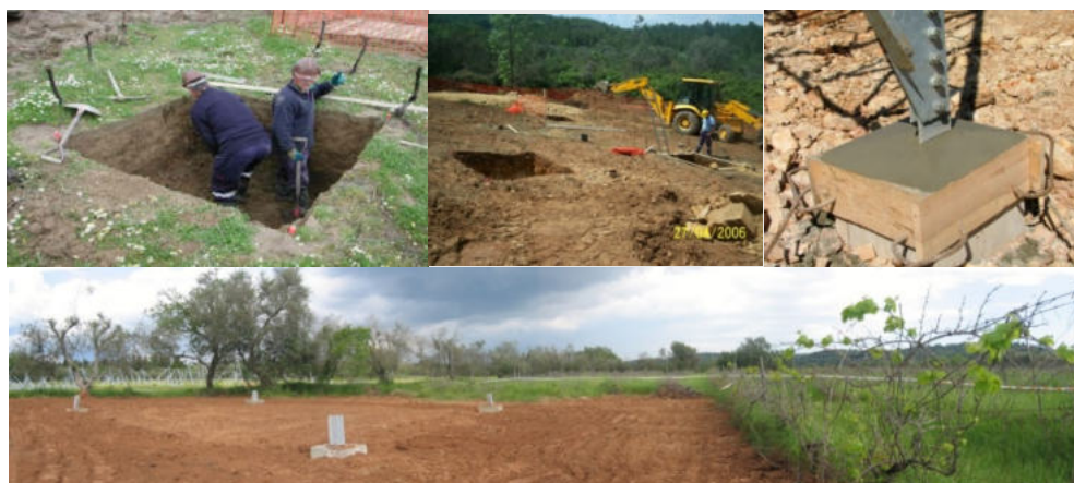
Figura 2.10 – Execução das fundações dos apoios da linha
