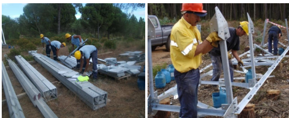
Figura 2.11 – Preparação da montagem da estrutura dos apoios
