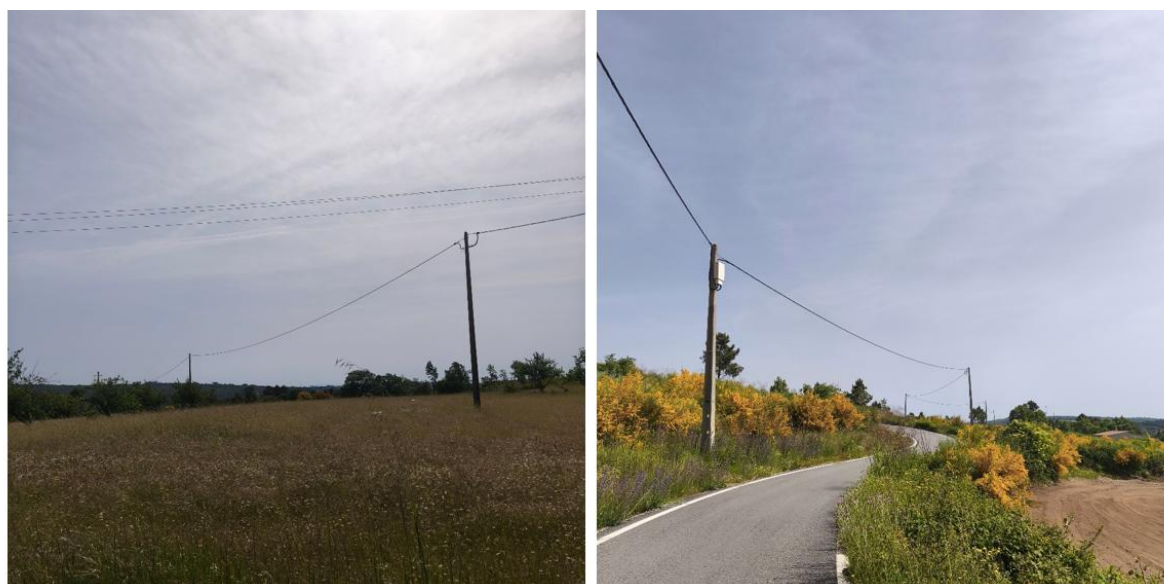
Figura 5-8: Linhas elétricas existentes na área de estudo (Visita de campo da KEO, maio 2026)
