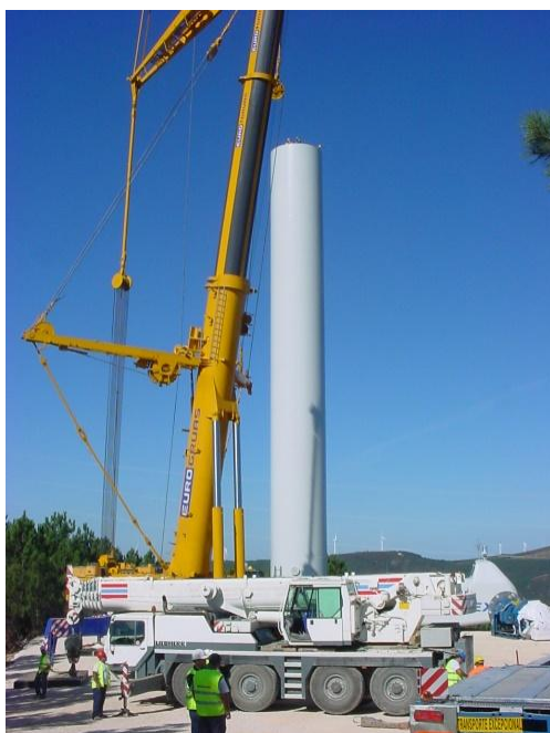
Figura 2.2 – Plataforma de trabalho adjacente a um aerogerador durante a fase de montagem
