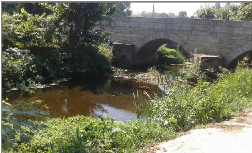
Figura 2 - Ponto de recolha 3 – Rio Sousa, a jusante da via, a cerca de 1000 m..
