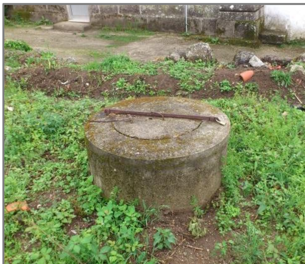
Figura 14 - Ponto de recolha 11 – Quinta da Lagoa - Poço ao km 7+800, a cerca de 500m a jusante da via.
