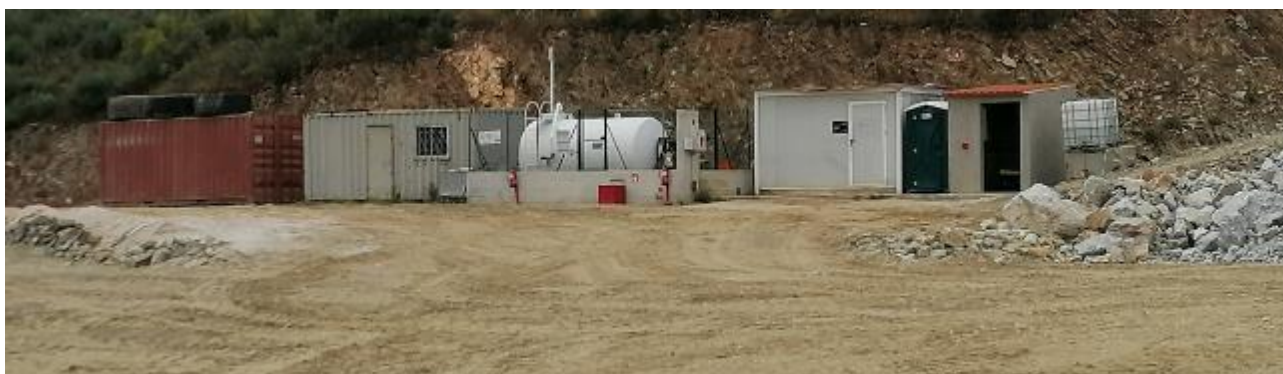
Figura 20 – Novas instalações de apoio
