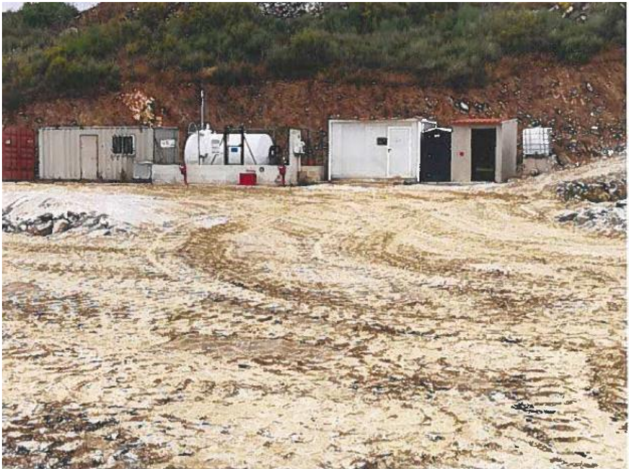
Figura 53 - Vista da Área Social e Ferramentaria Fonte: Visita à Mina 17 de maio de 2024
