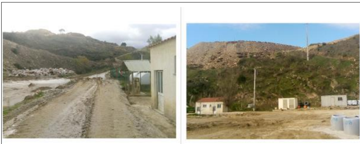
Figura 17 - Antigas instalações de apoio da Mina entretanto dismanteladas
