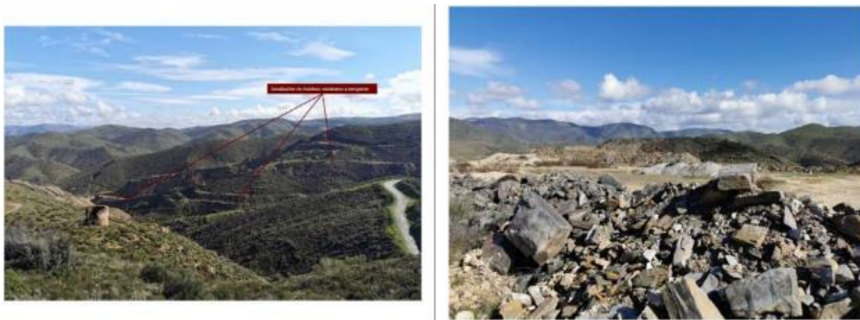
Figura 37 - Escombros existentes no Núcleo A
