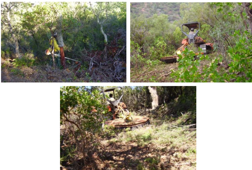
Fotografias 4, 5 e 6 – Limpeza de vegetação arbustiva à volta das árvores de maior porte e abertura de ruas com recurso a destroçador de eixo horizontal.
