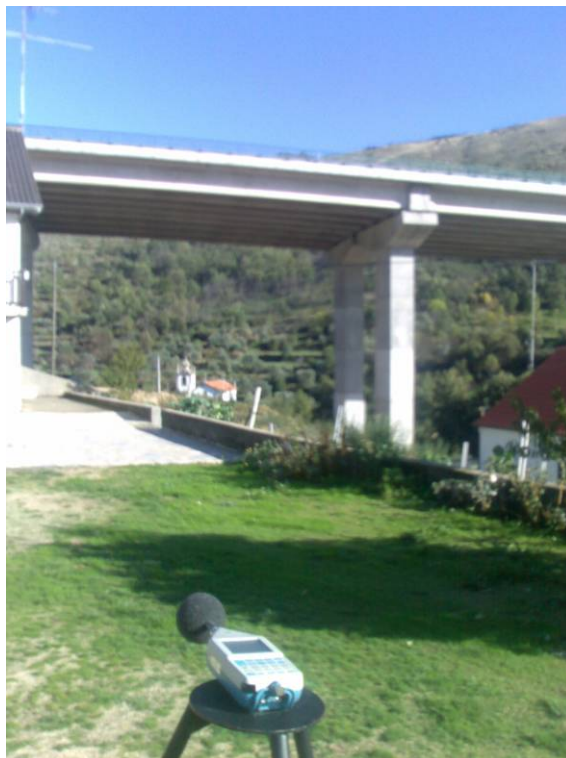
Fotografia do ponto de medição de ruído 52 (Habitações próximas do viaduto com barreiras acústicas)
