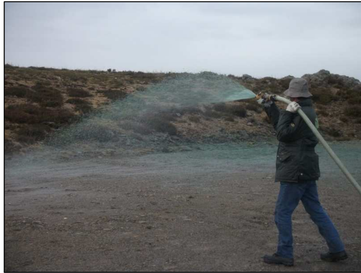
Figura 3 – Hidrossementeira das plataformas dos aerogeradores
