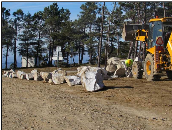
Figura 2 – Colocação de pedra nas plataformas dos aerogeradores
