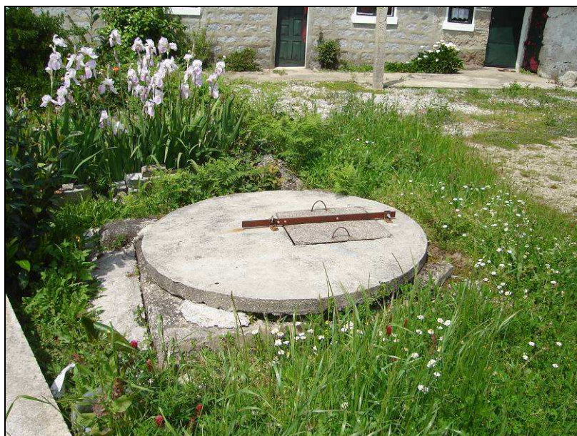
Figura 3.11 – Ponto de recolha 11 – Poço 63A
