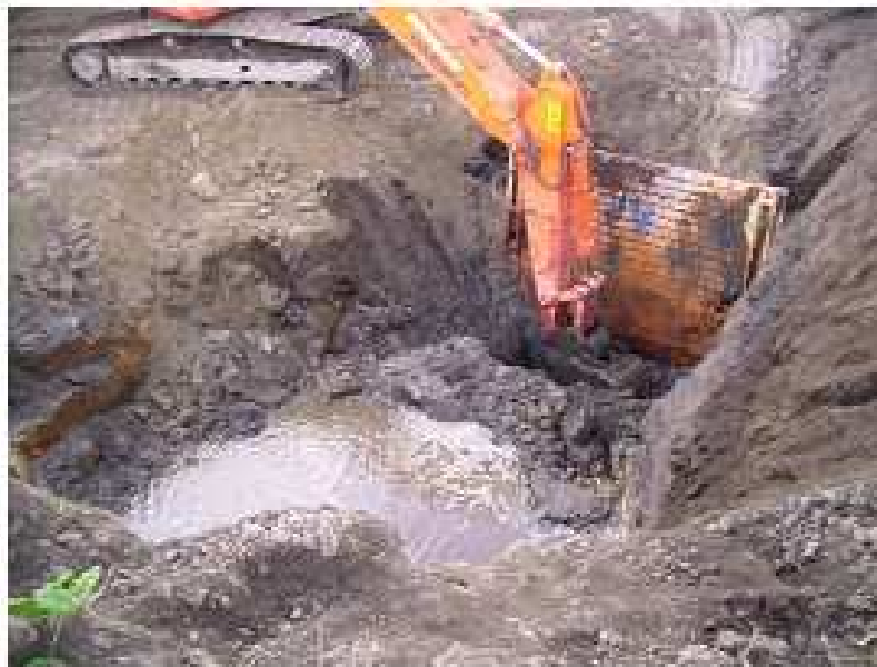
Figura 7.3.11 Trabalhos de escavação na caixa IF 01
