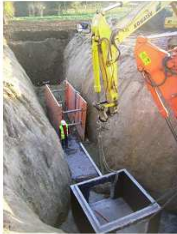
Figura 7.3.10 Trabalhos de escavação na caixa S.E.02
