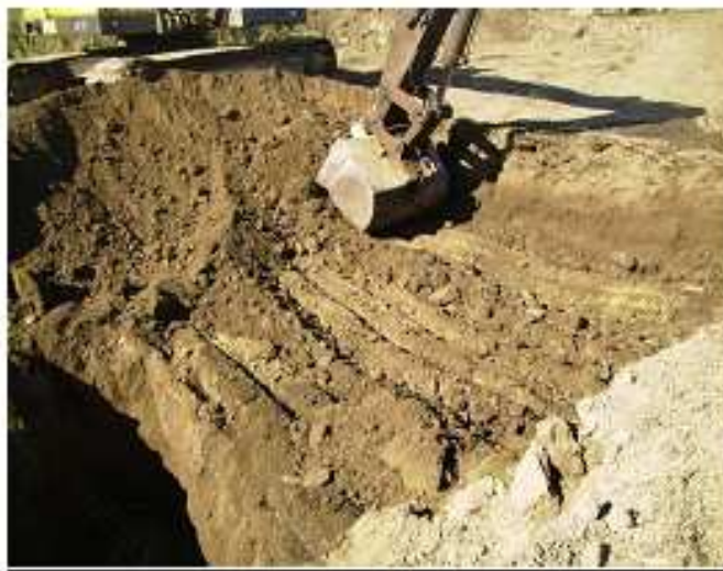
Figura 7.3.1- Escavação na estaca S.E. 05 cx
