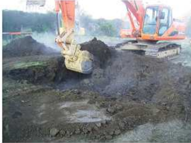
Figura 7.3.3- Trabalhos de escavação na estaca S.E. 05 cx
