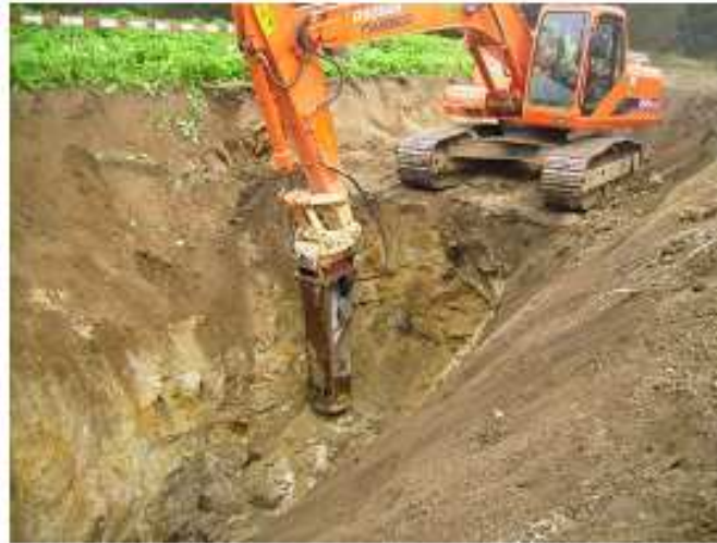
Figura 7.3.4 Trabalhos de escavação em direcção à estaca S.E. 04.
