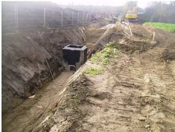
Figura 7.3.7 Fotografia geral do trabalho
