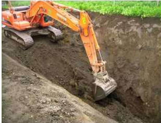
Figura 7.3.8 Trabalhos de escavação em direcção à estaca IF 01 cx
