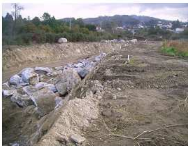
Figura 7.3.12 Trabalhos de escavação e a rampa de acesso para os camiões do outro lado do rio, junto à ETAR velha.
