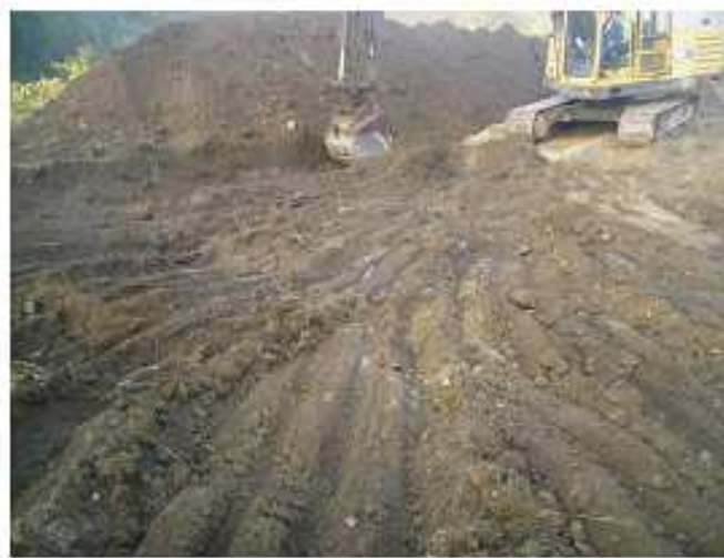
Figura 7.3.2- Alargamento na estaca S.E. 05 cx
