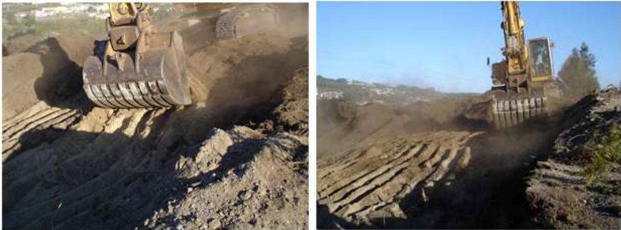
Figura 6.2.4 - Trabalhos de escavação da camada vegetal.
