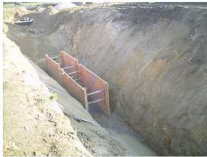
Figura 7.3.13 Trabalhos de escavação em direcção à estaca S.E.03 cx
