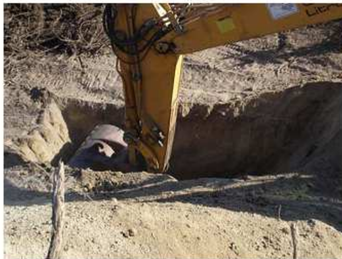
Figura 6.2.3.1 - Trabalhos de escavação das sondagens para análise do solo.
