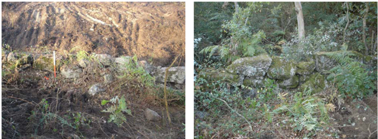
Figura 6.1- Muro de divisão de terras.
