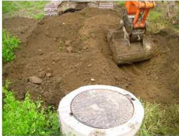
Figura 7.3.9 Trabalhos de escavação na estaca S.E.01 cx.
