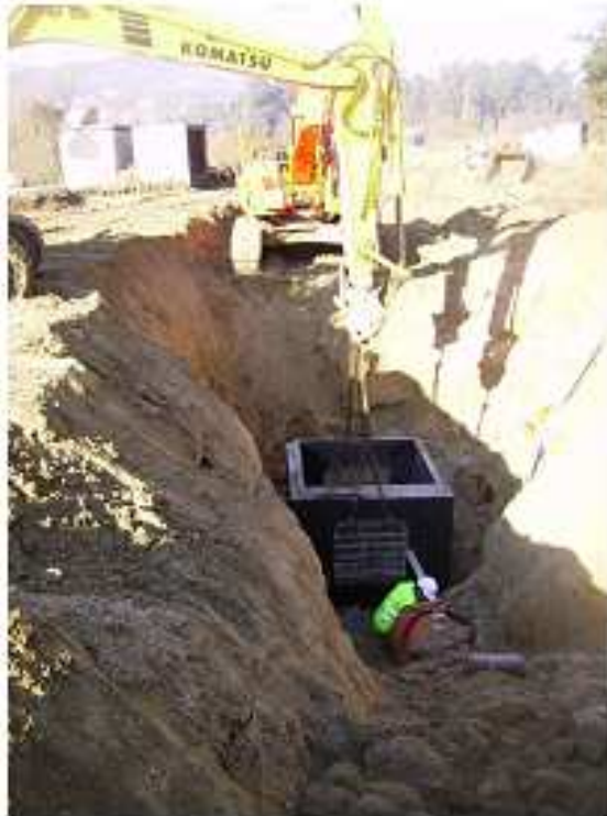
Figura 7.3.14 Colocação da caixa S.E.03
