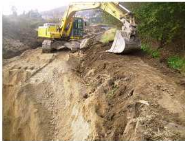
Figura 7.3.6 Sondagem depois da estaca S.E.03 para retirar saibro.
