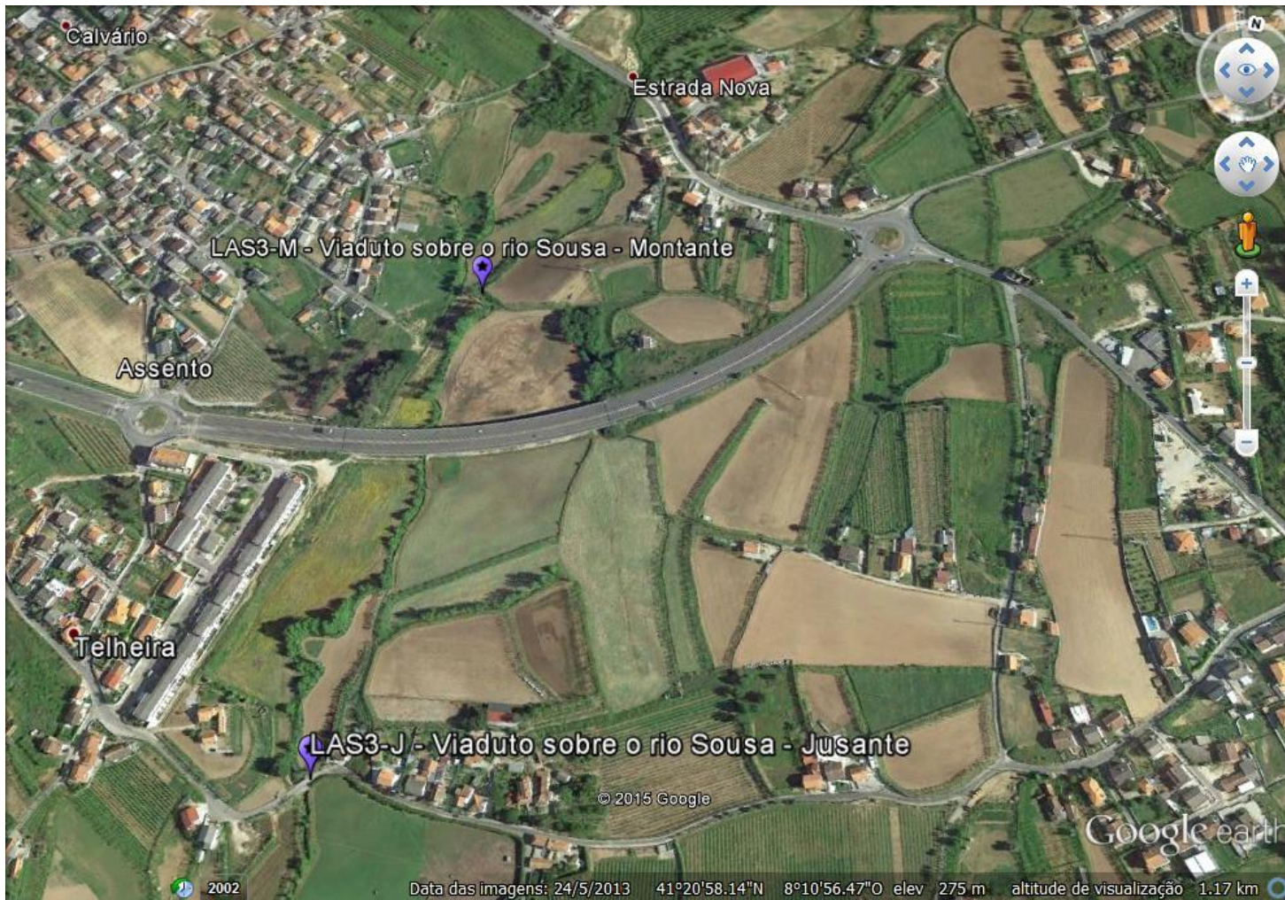
Figura A1.3 – Localização dos pontos de amostragem de águas superficiais (imagem retirada do Google Earth).
