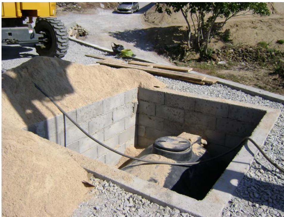
Instalação de separador de gorduras
