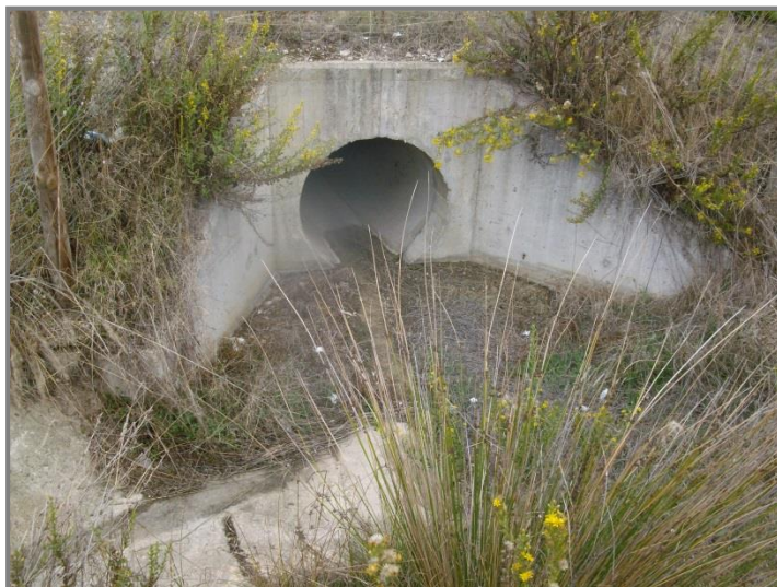
Figura 10 - Ponto de recolha km 8+154 (lado esquerdo da via).
