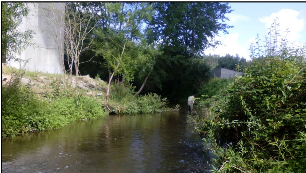
P2 – Troço do rio Uíma na zona de descarga das águas de escorrência da Ponte sobre o Rio Uíma – pk 8+770 (km 48 de exploração)
