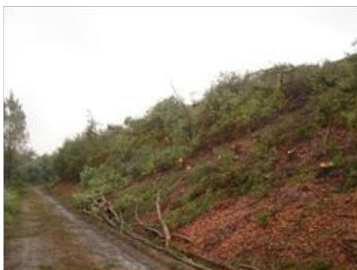
Fig. 1 – Início da desmatção no aterro de cinzas (06-10-10)
