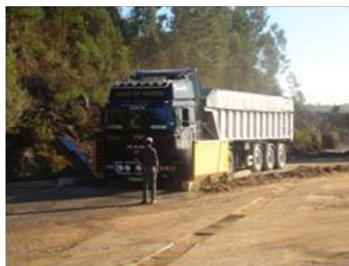
Fig. 2 – Lavagem dos rodados à saída da obra e cobertura dos camiões com lonas (08-10-10)
