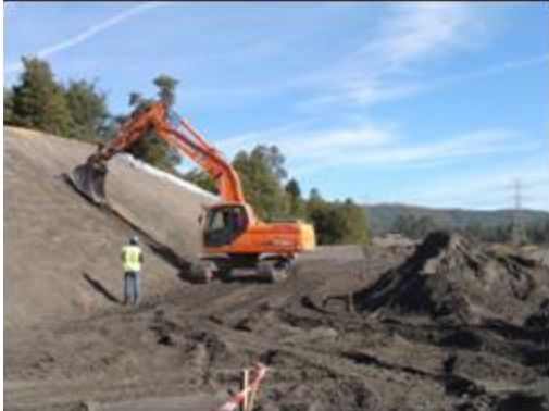
Fig. 14 – Remoção de cinzas e início de tratamento de talude - revestimento com geotêxtil (29-10-10)
