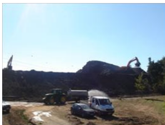
Fig. 5 – Regas periódicas em tempo seco das frentes de escavação (13-10-10)
