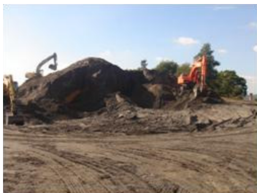
Fig. 3 – Escavação das cinzas (11-10-10)
