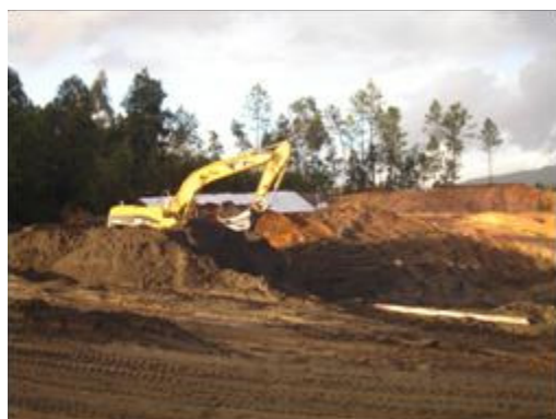
Fig. 12 – Regularização de taludes para posterior tratamento final (26-10-10)
