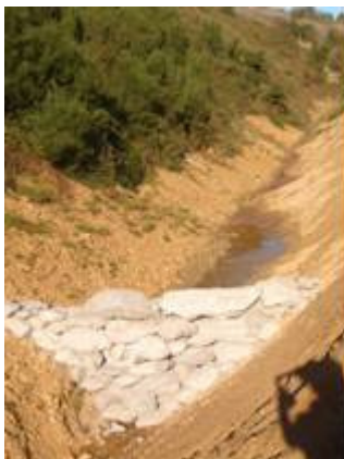
Fig. 8 – “Cordão de Terras” junto ao km inicial da zona de intervenção das cinzas (18-10-10)
