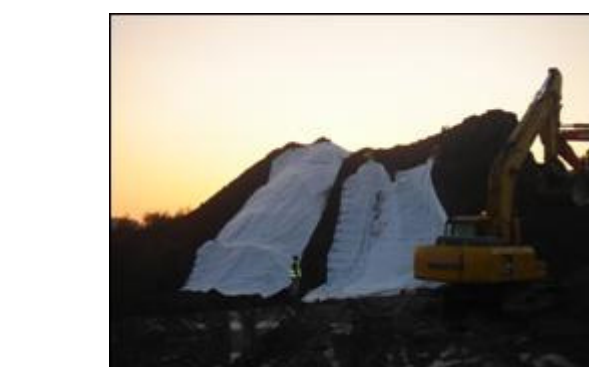
Fig. 6 – Cobertura dos taludes de escavação com geotêxtil (13-10-10)
