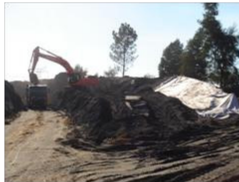
Fig. 9 – Continuação dos trabalhos de remoção das cinzas e cobertura de taludes com geotêxtil (19-10-10)
