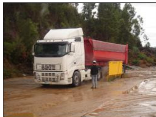
Fig. 4 – Lavagem dos rodados à saída da obra e cobertura dos camiões com lonas (12-10-10)
