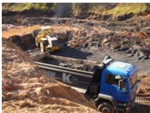
Fig. 10 – Remoção das cinzas existentes na bacia de decantação n.º 3 (19-10-10)
