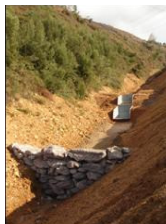
Fig. 11 – “Cordão de Terras” e Bacia de Decantação implementados junto ao km inicial da zona de intervenção das cinzas (25-10-10)
