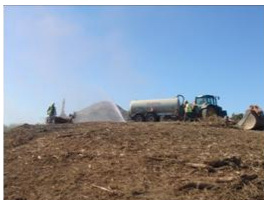
Fig. 5 – Regas periódicas em tempo seco das frentes de escavação (13-10-10)
