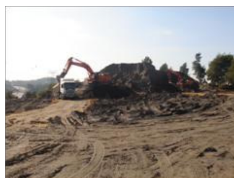
Fig. 7 – Continuação dos trabalhos de escavação e transportes das cinzas (15-10-10)
