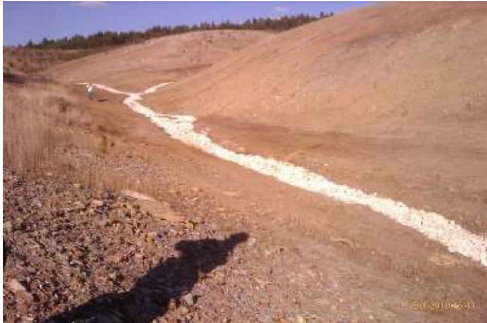
Figura 20. Vista das linhas de água após a colocação de enrocamento calcário.
