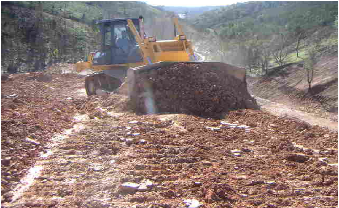
Foto 7 - Abertura de caminho na área da Plataforma
