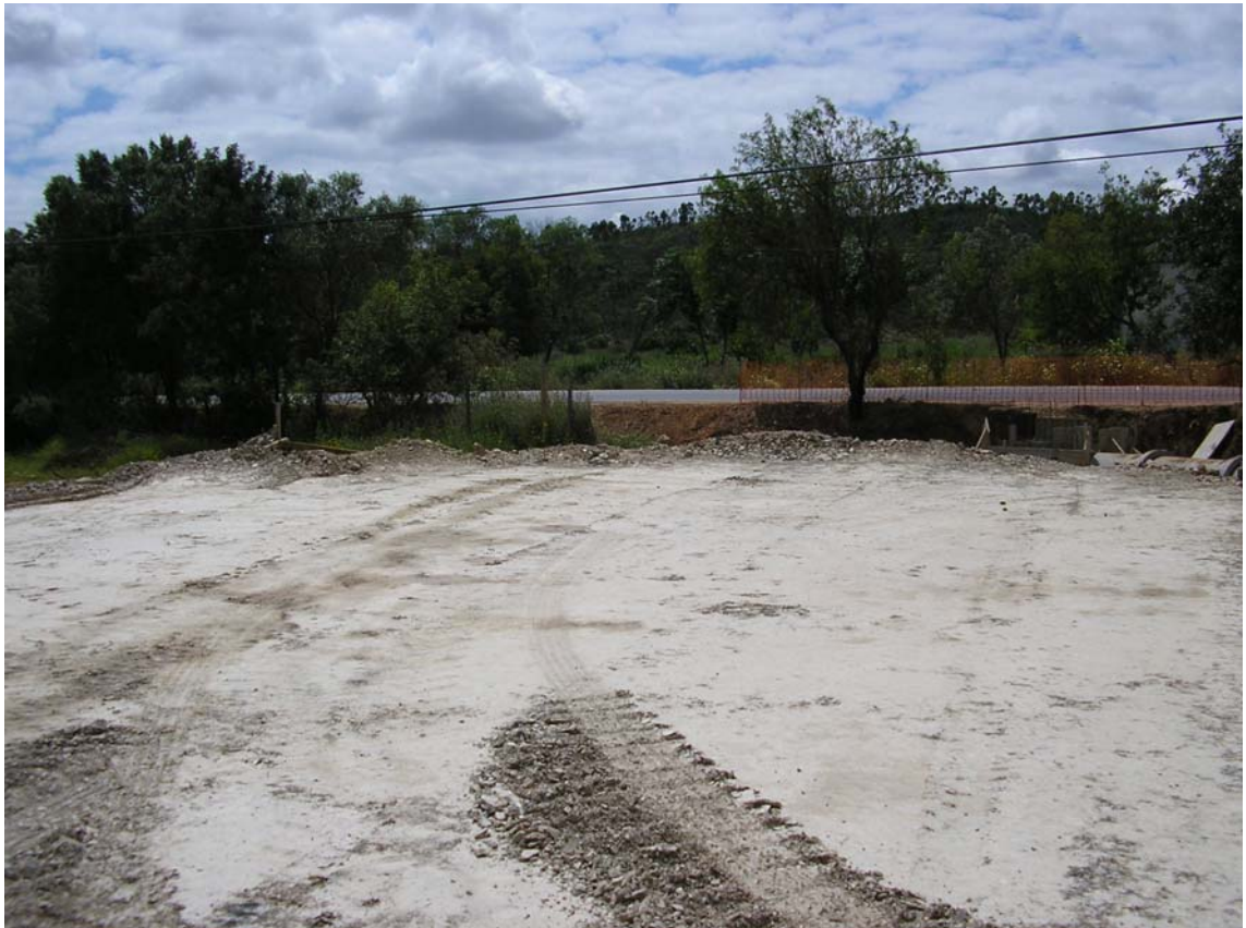
Foto 14 – Limite do caminho de acesso junto à EN 124
