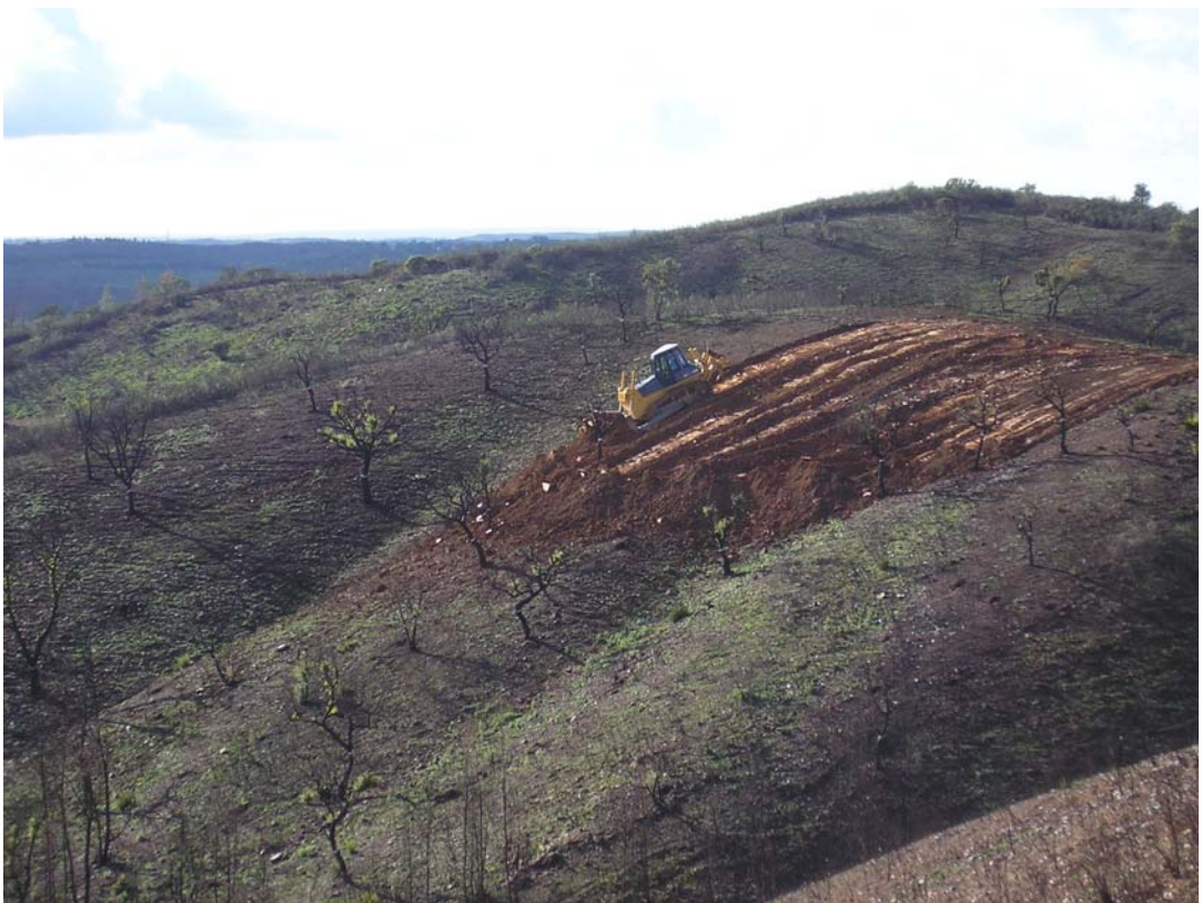
Foto 4- Início dos trabalhos de decapagem na área da plataforma
