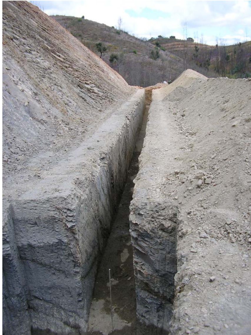
Foto 9 – Vala de drenagem na área da plataforma
