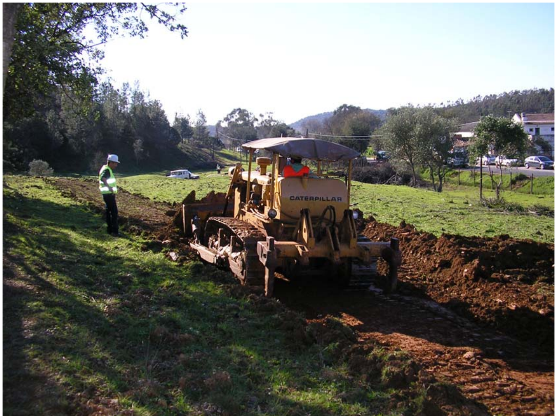
Foto 2 - Trabalhos de terraplenagem para implantação do estaleiro social
