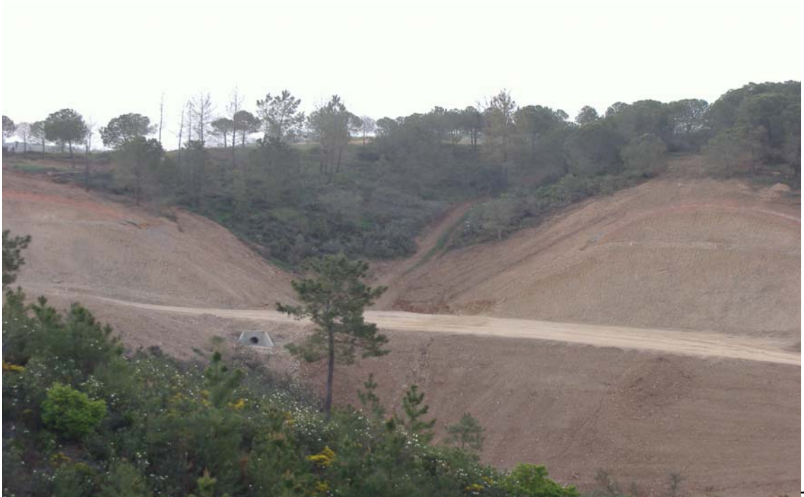
Foto 12 – Aspecto de Banqueta na estrada de acesso
