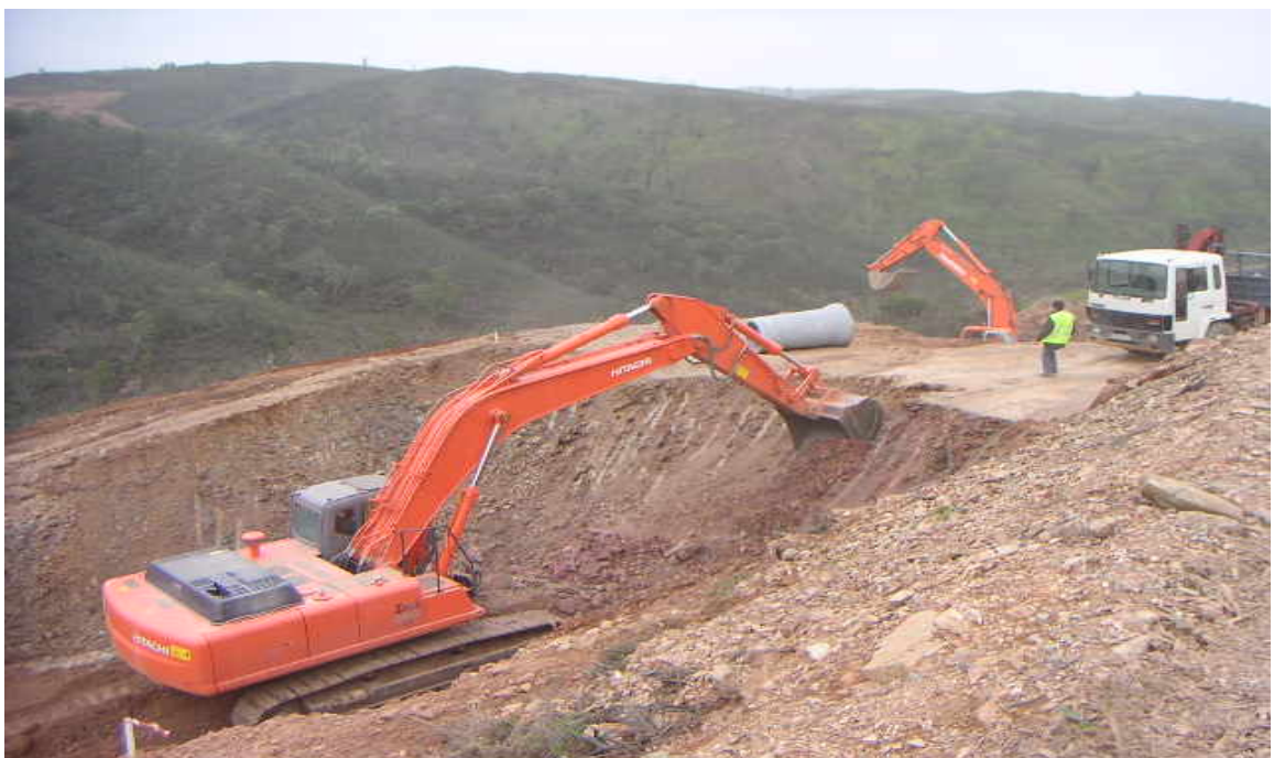
Foto 6 - Escavação na área da Plataforma
