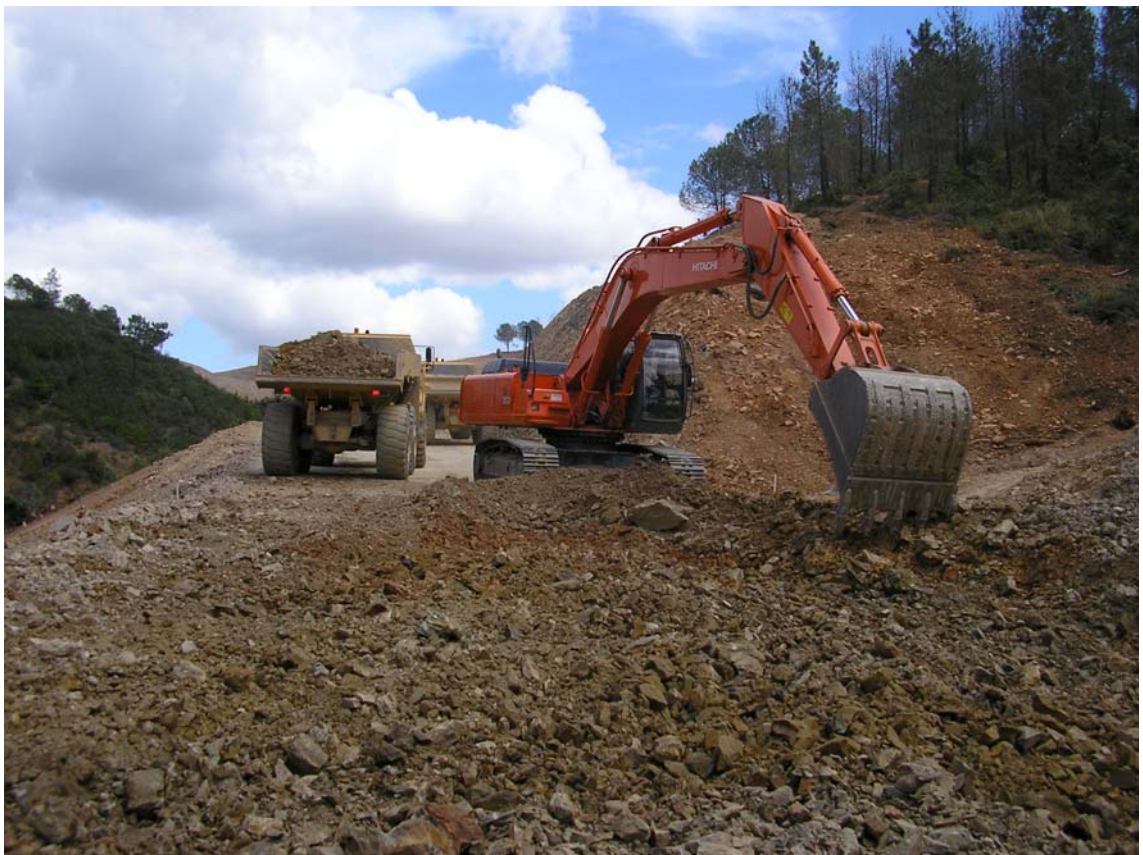
Foto 13 – Escavação para nivelamento do caminho de acesso
