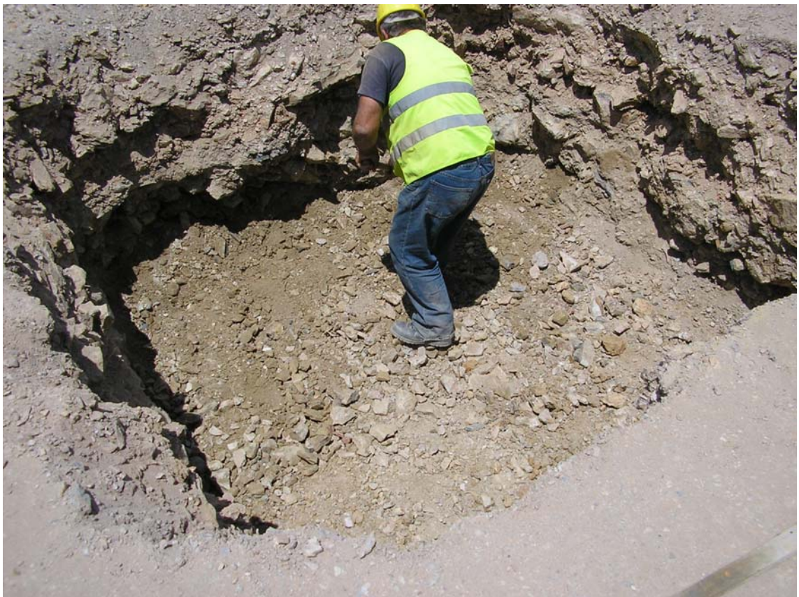
Foto 8 – Escavação de maciços na plataforma
