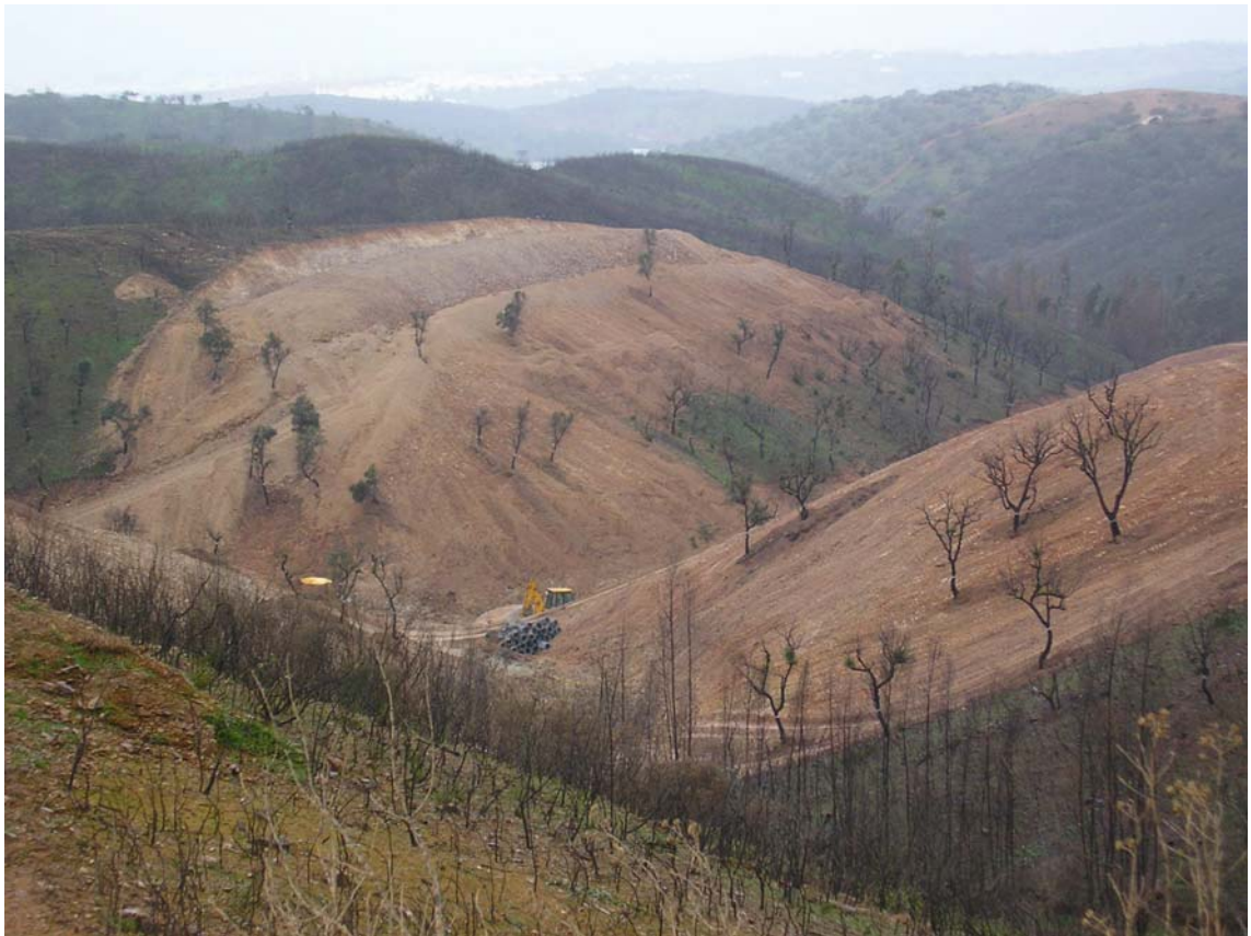
Foto 5- Aspecto parcial da área após a decapagem
