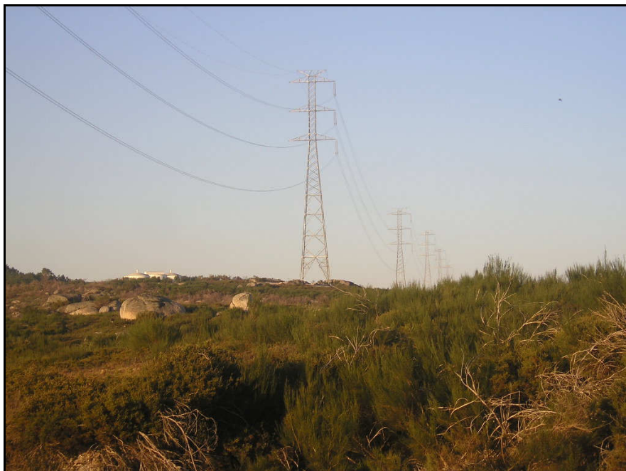
Figura 11 – Aspecto geral da área do troço BV7.
