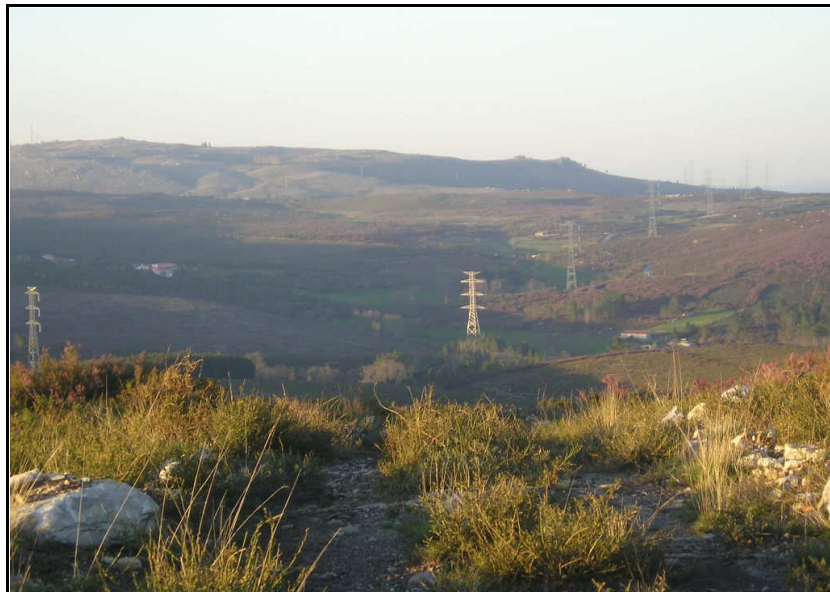
Figura 13 – Aspecto geral da área do troço BV9.
