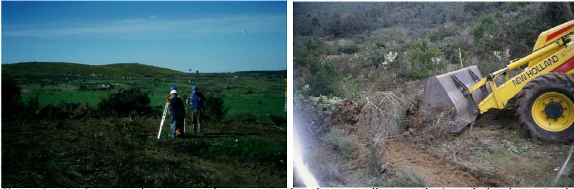
Figura 3 e 4 - Decorrer do processo de marcação de caboucos e limpeza da área de implantação de um apoio.
