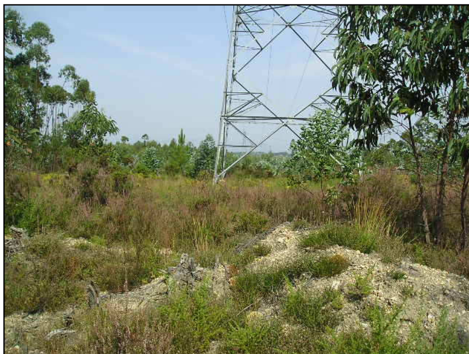
Fotografia 14 – Troço PS5, aspecto geral.
