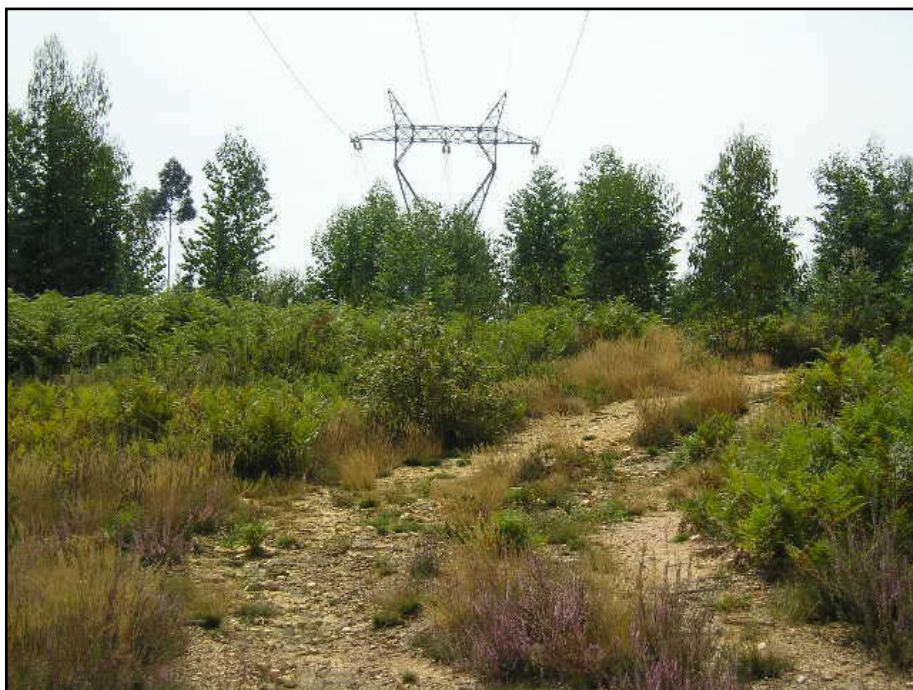
Fotografia 13 – Troço PS5, entre P58 e P59.
