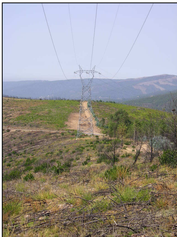
Fotografia 1 – Vista geral do troço PS1 entre o P6 e o P7.
