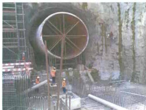
Figura 1: Trabalhos na Galeria 1.
