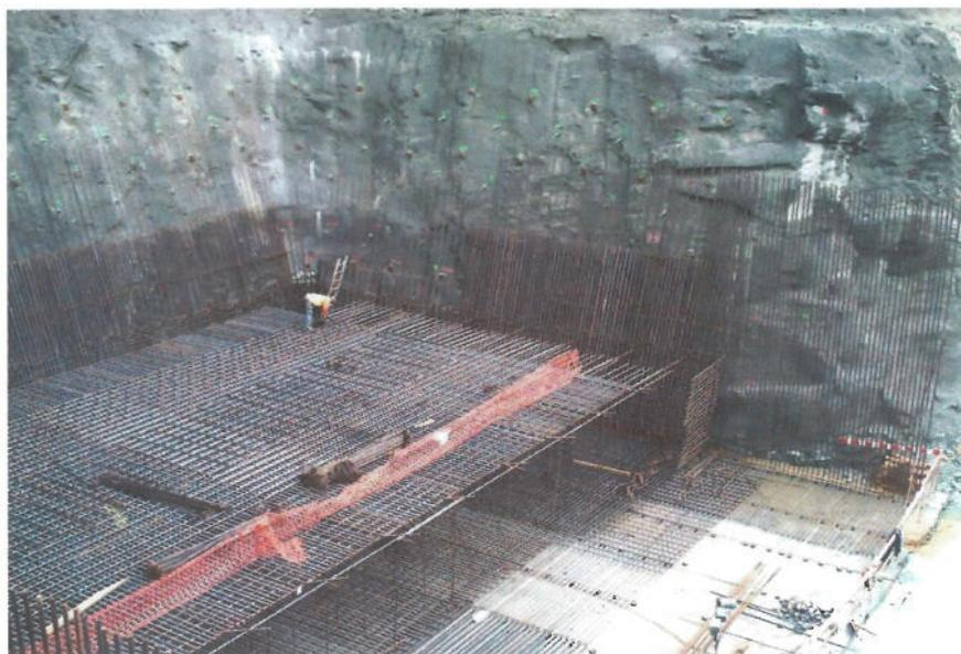
**Fig. 2 – Aspecto da fase de montagem das armaduras da laje**
