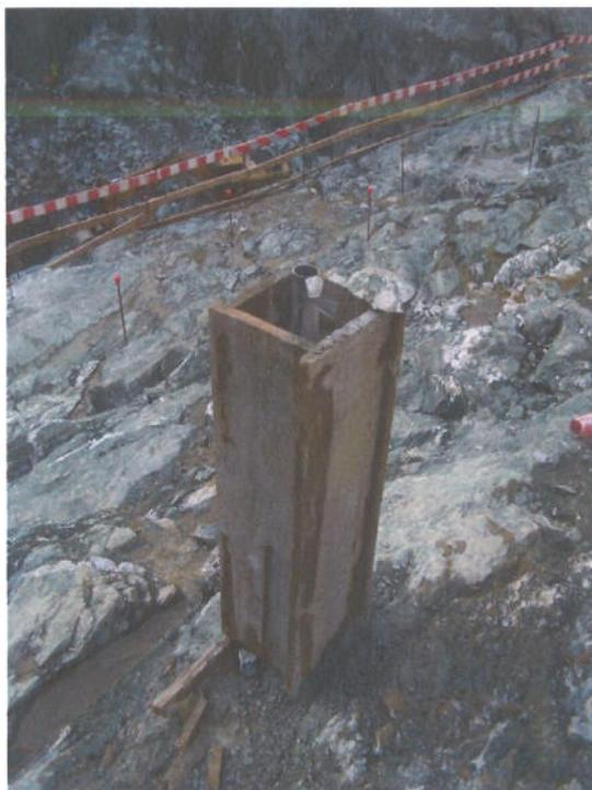
**Fig. 15 – Central. Instalação do piezómetro 4**
