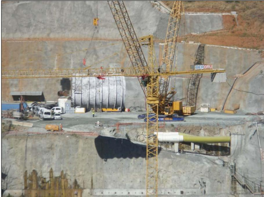
Foto 3.8 – Descida e posicionamento da plataforma de apoio dos tubos da BGA, na laje do difusor do Grupo 2, à cota 55.00.
