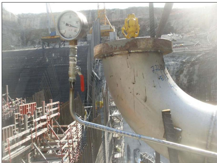
Foto 3.22 – Ensaio hidráulico da tubagem de afogamento e purga da câmara da válvula (229) do Grupo 2
