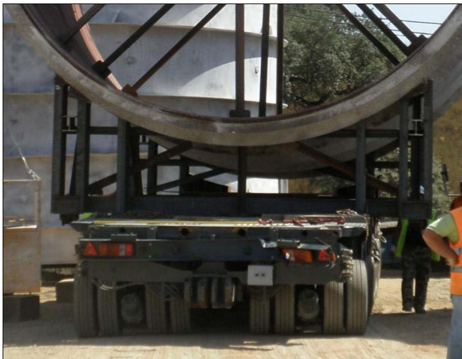
Foto 3.2 – Apoio da transição cônica para transporte e ripagem para o interior da galeria
