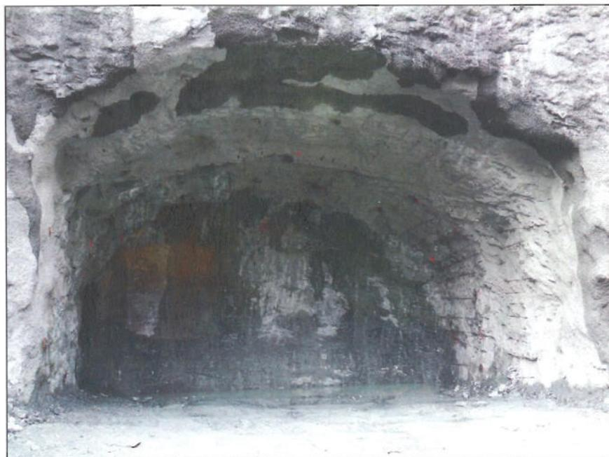
Fig. 12 – Tomada de Água – Emboquilhamento da galeria de adução 1
