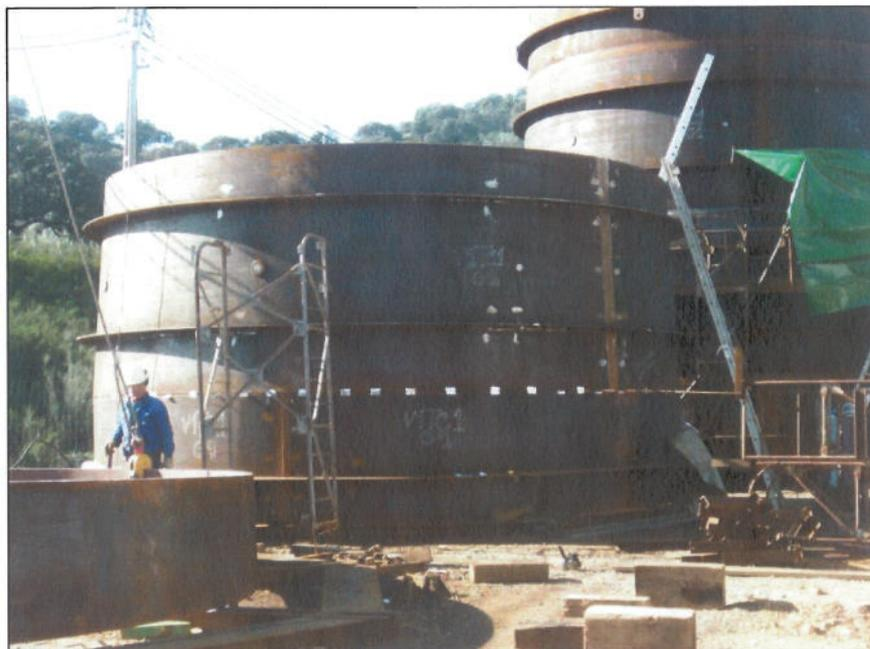
Fig. 31 – Transição cônica 1 – virolas 1 e 2 - soldadura radial
