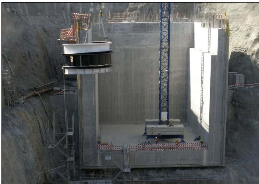
Foto 3.18 – Descida da 1ª metade do antedistribuidor do Grupo 1 no interior do átrio de montagem.
