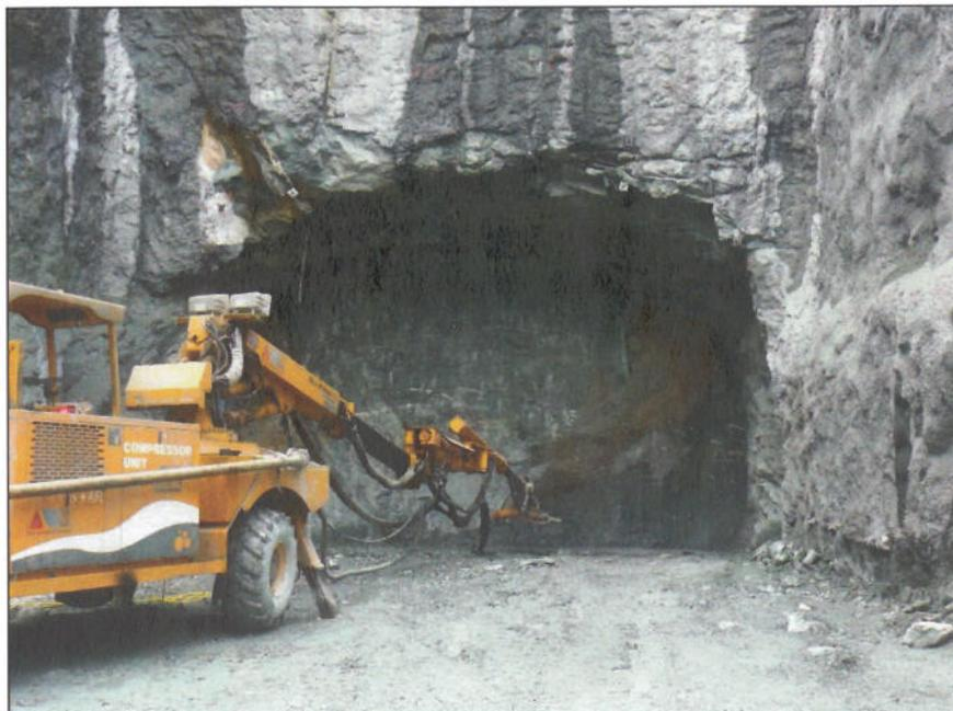
Fig. 13 – Tomada de Água – Emboquilhamento da galeria de adução 2
