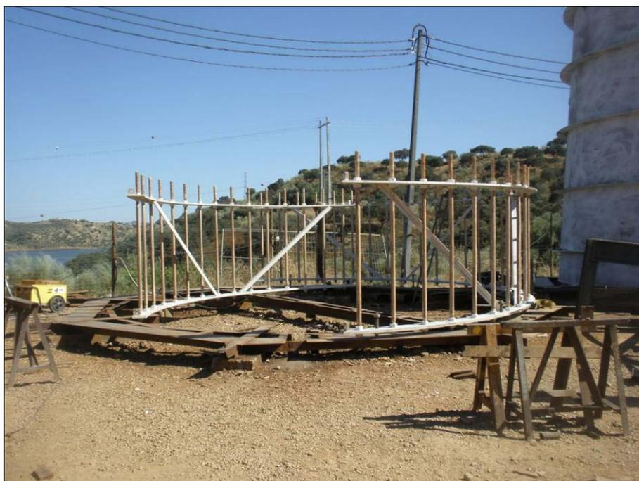
Foto 3.15 – Posicionamento no plano, para posterior soldadura da ancoragem do antedistribuidor do Grupo 1
