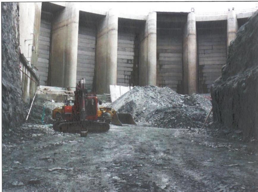
Fig. 11 – Tomada de Água – Escombro retirado da escavação subterrânea
