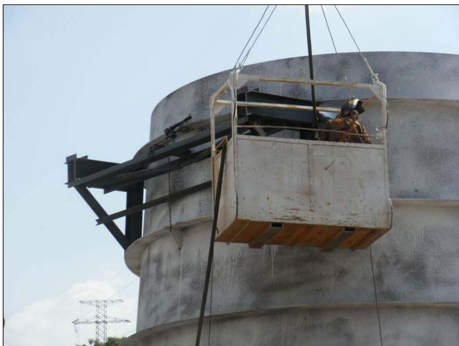
Foto 3.1 – Trabalhos de serralharia e soldadura, para montagem de apoios nas transições cónicas 1 e 2 das BGA dos Grupos 1 e 2
