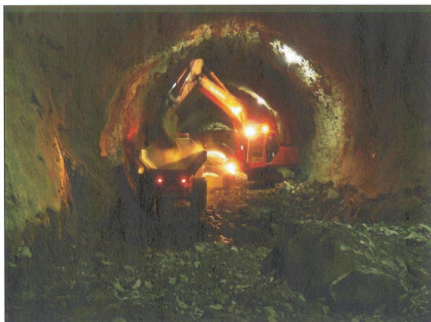
Fig. 24 – Galeria de Adução 1 – Remoção do escombro remanescente do rebaixo do lado de jusante
