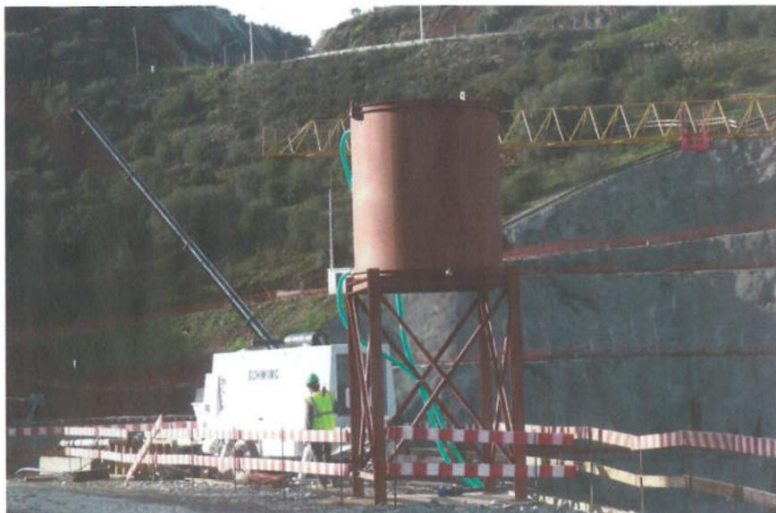
**Fig. 28 – Preparação do sistema de bombagem de betão**
