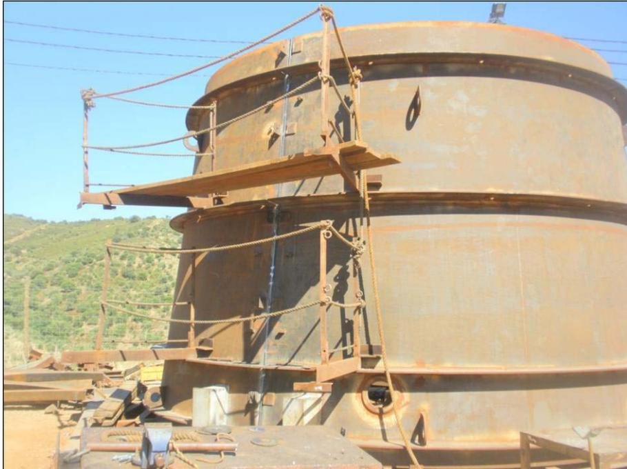
Foto 3.26 – Soldadura longitudinal exterior das telhas do Grupo 2
