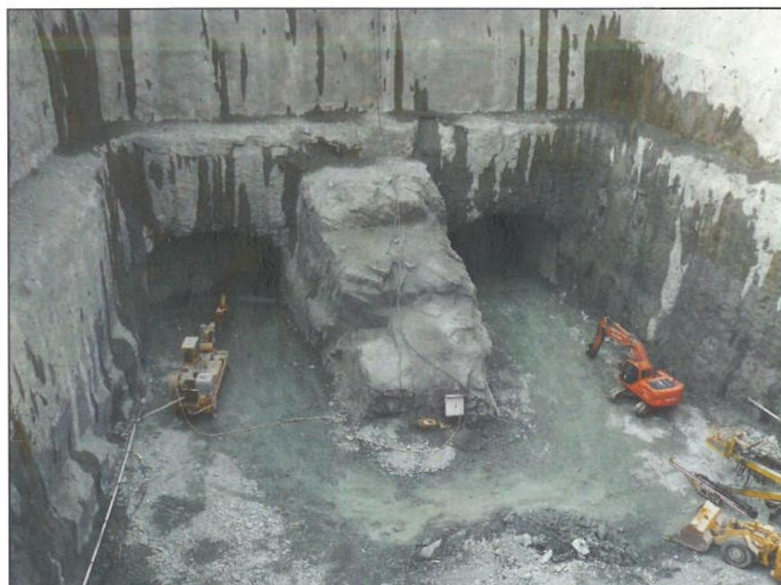
Fig. 10 – Tomada de Água – Emboquilhamento das galerias de adução
