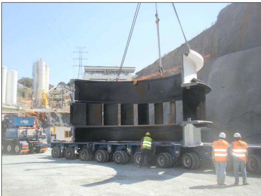
Foto 3.17 – Içar da metade do antedistribuidor com a grua CC1800SSL para descarga no átrio de montagem.
