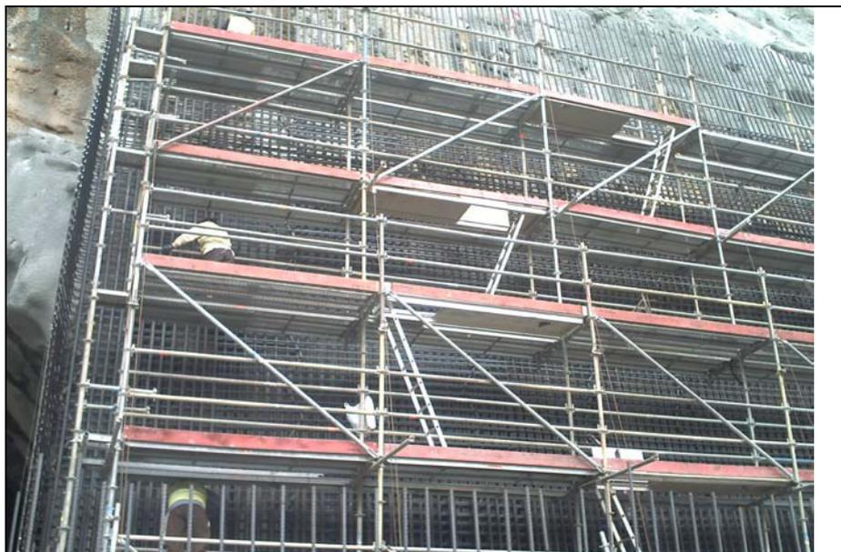
Foto 2.23 – Central. Montagem da armadura de parede no TC6 (07/07/2010)
