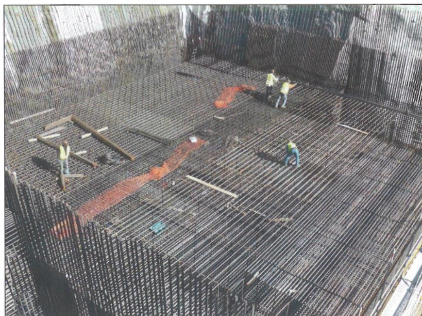
Fig. 20 – Central – Continuação da montagem da armadura da laje do átrio de descarga
