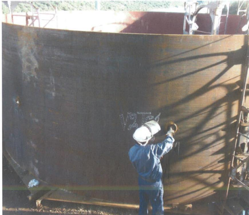
*Fig. 7 – BGA G2. Transição cônica 1, virola 2. Soldadura longitudinal*
