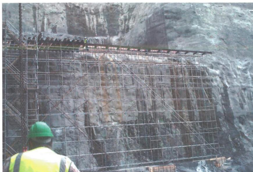
**Fig. 3 – Montagem de cimbre para execução da zona saliente da laje**
