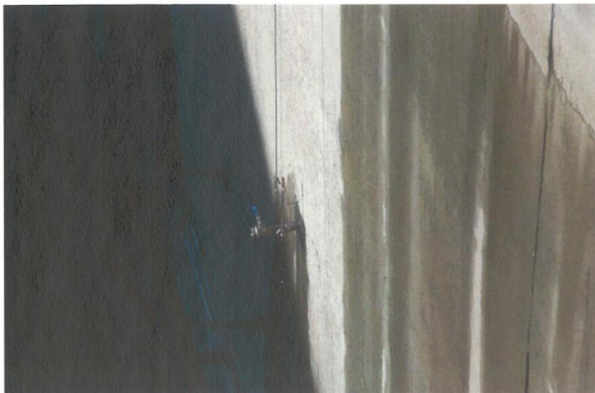
*Fig. 27 – Instalação de manómetro e torneira para piezómetro na Tomada de Água*
