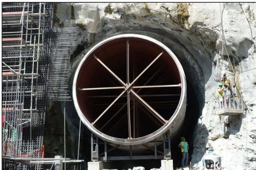
Foto 7.15 – Circuito hidráulico 1 - G1 – Posicionados os tubos e transição da BGA
