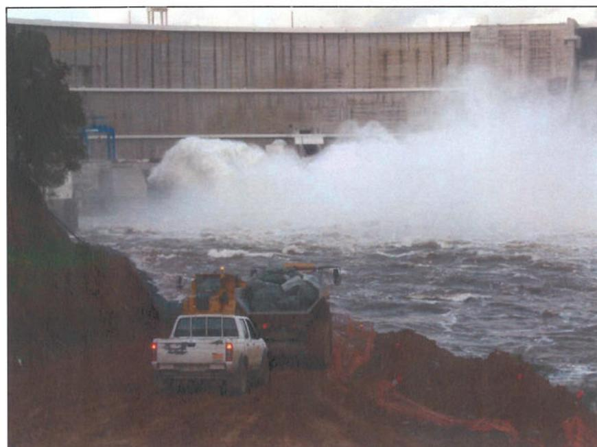
Fig. 6 – Transporte de escombro para construção de dique sobre a ensecadeira de jusante
