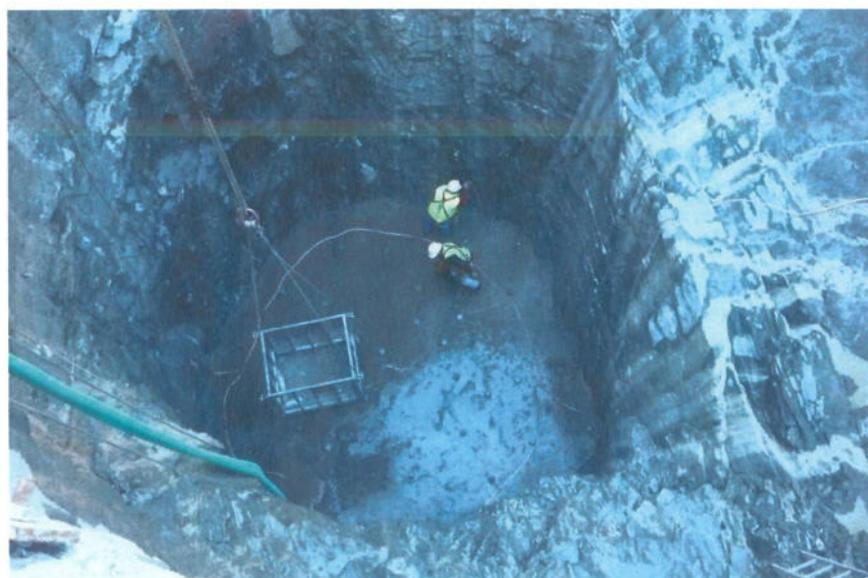
**Fig. 29 – Montagem de rede de terras no poço de drenagem**
