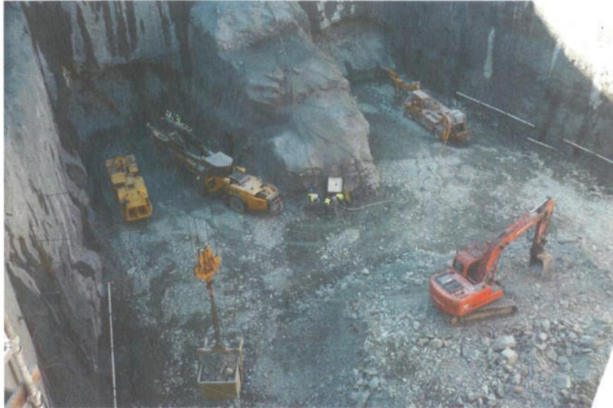
**Fig. 26 – Emboquilhamentos das galerias na Tomada de Água**
