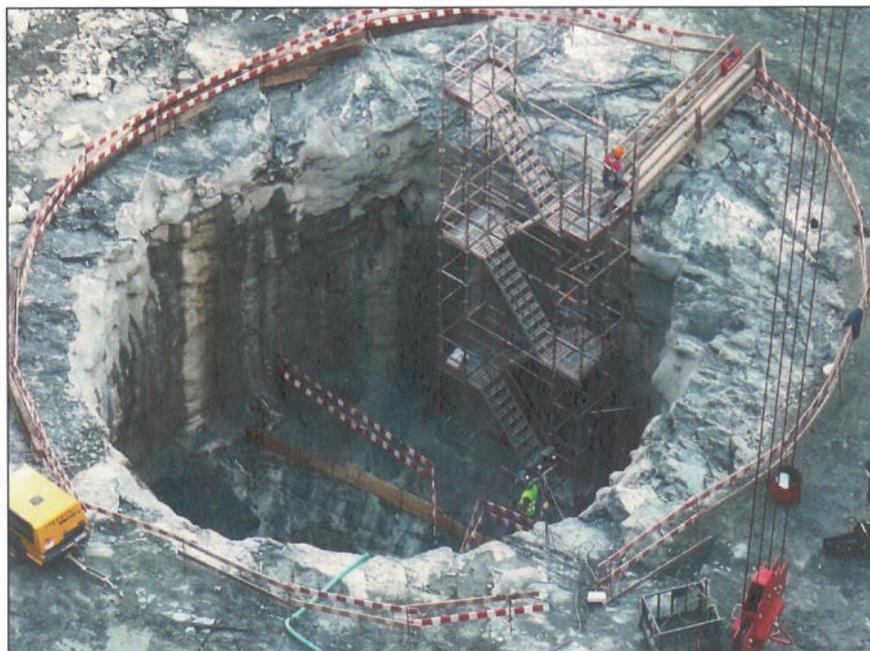
Fig. 17 – Central – Poço de bombagem
