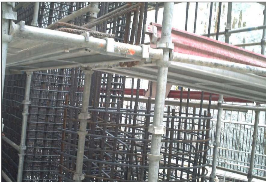
Foto 2.2 – Tomada de Água. Fase de montagem do septo
