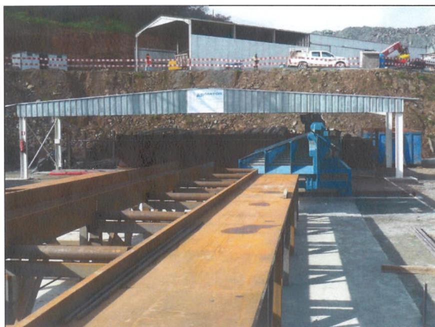
Fig. 28 – Estaleiro Industrial – zona de corte e moldagem de aço para betão armado
