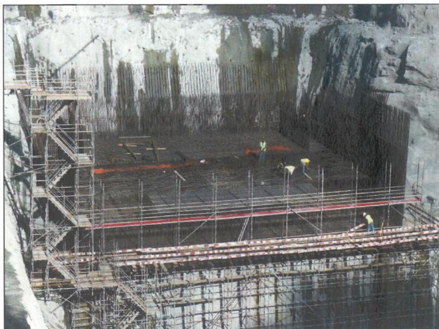
Fig. 19 – Central – Continuação da montagem da armadura da laje do átrio de descarga
