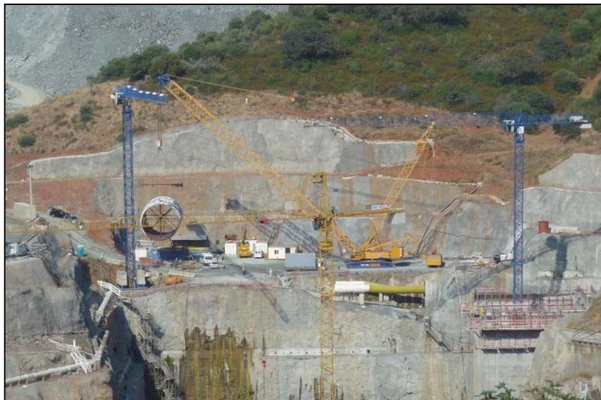
Foto 7.14 – Central. Descida e posicionamento das BGA's.
