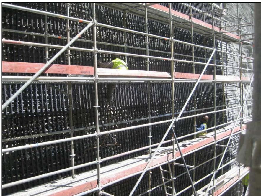
Foto 2.26 – Central. Fase de montagem da armadura da parede Norte
