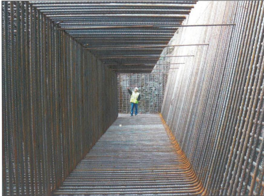
Fig. 21 – Central – Continuação da montagem da armadura da laje do átrio de descarga
