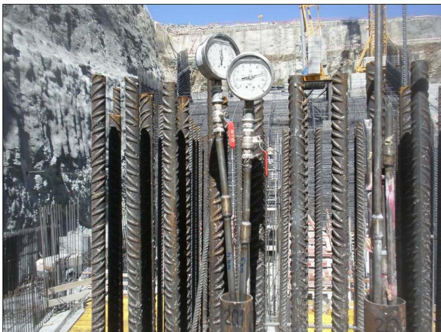
Foto 3.14 – Ensaio hidráulico, da tubagem de tomada de pressão no cotovelo de aspiração (201) do Grupo 1
